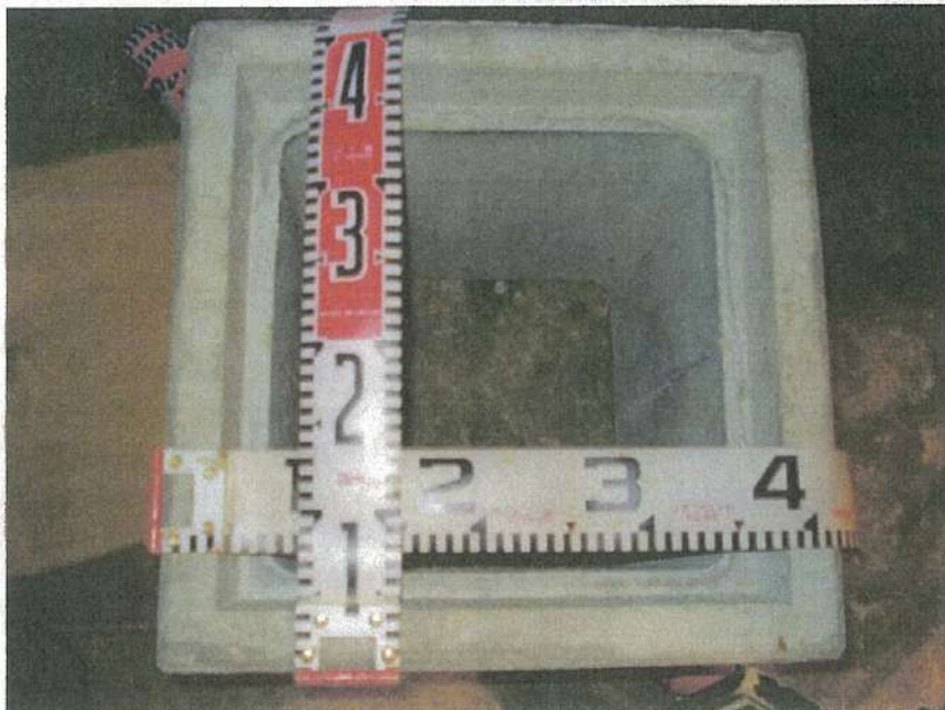
一般取扱所工事 強制換気交換工事 溜め枠検収 内径 300×300 H=450
