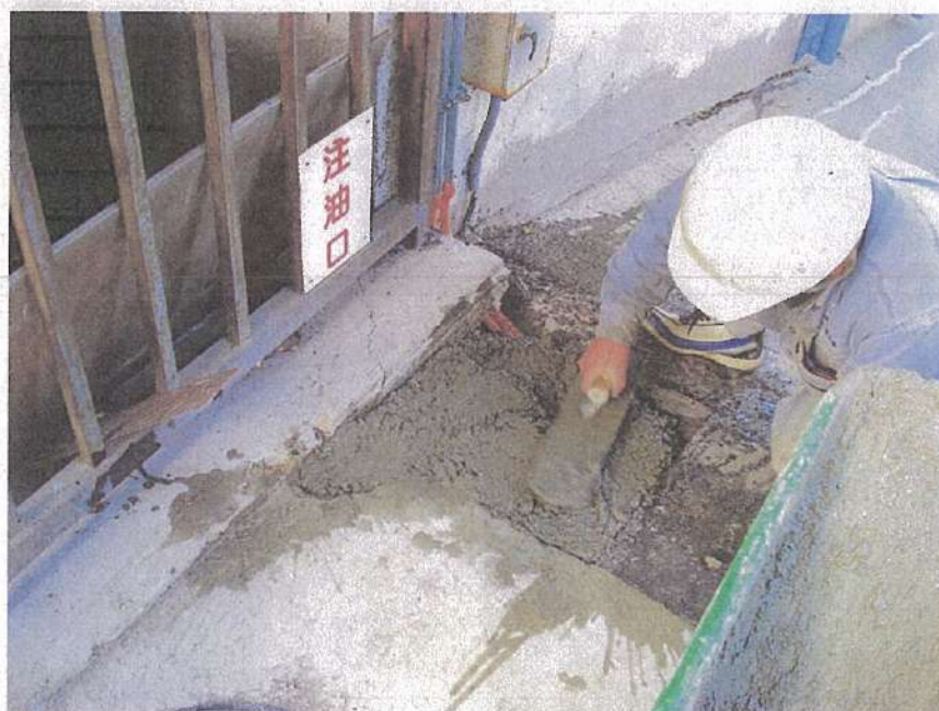
一般取扱所工事 補修工事 既存遠方注油口 コンクリート打設状況
