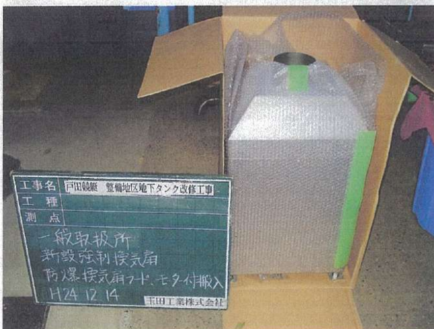
一般取扱所工事 強制換気交換工事 新設強制換気搬入 防爆仕様
