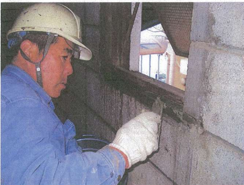
一般取扱所工事 補修工事 内部壁 モルタル補修状況
