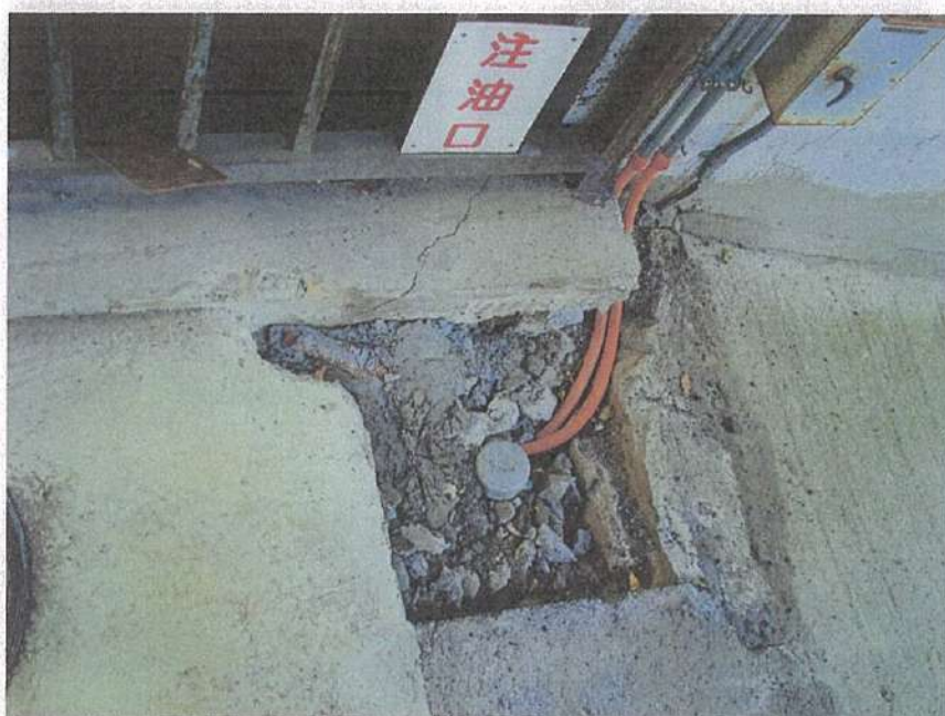
一般取扱所工事 補修工事 既存遠方注油口 土間合わせ砕り状況
