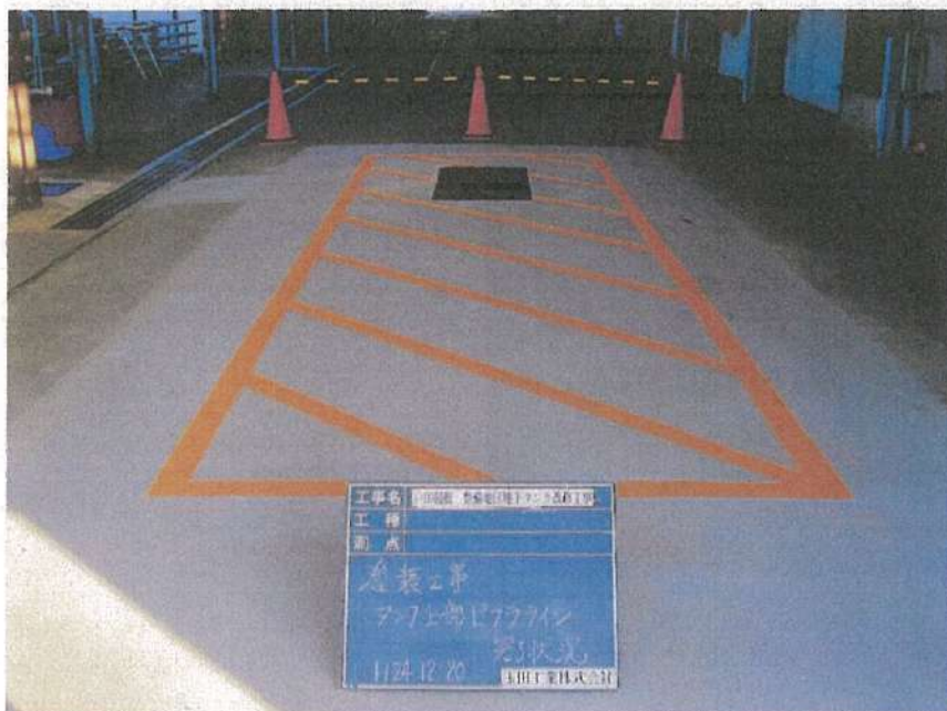
地下タンク設置工事 塗装工事 タンク上部ゼブラ塗布 完了状況
