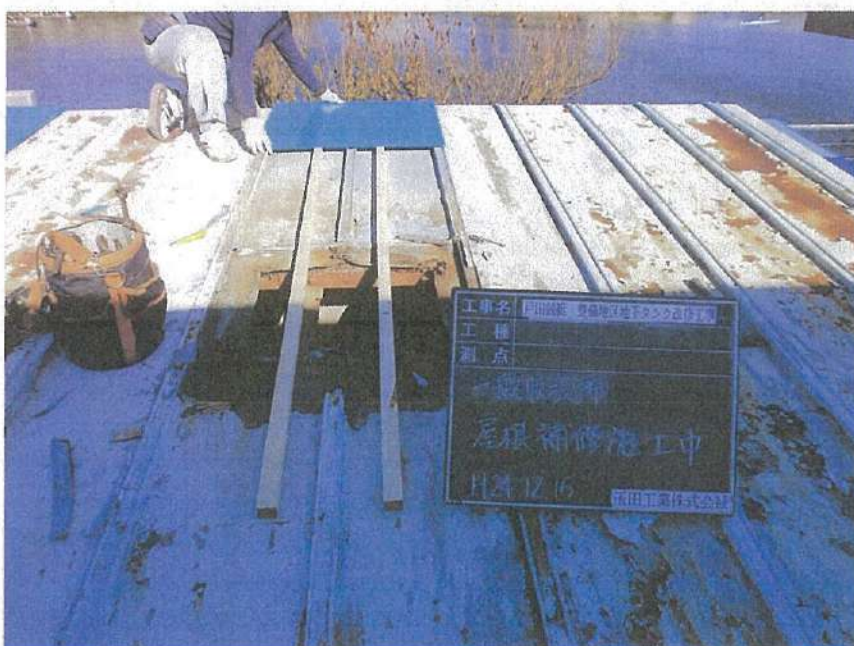
一般取扱所工事 屋根上換気塔 撤去工事 屋根復旧状況 下地取付
