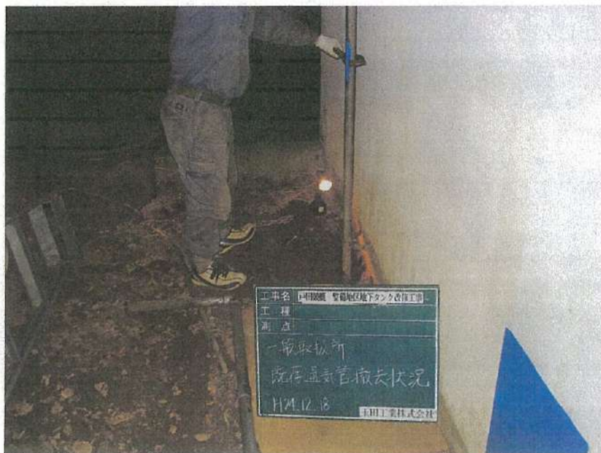
一般取扱所工事 解体工事 既存通気管撤去状況
