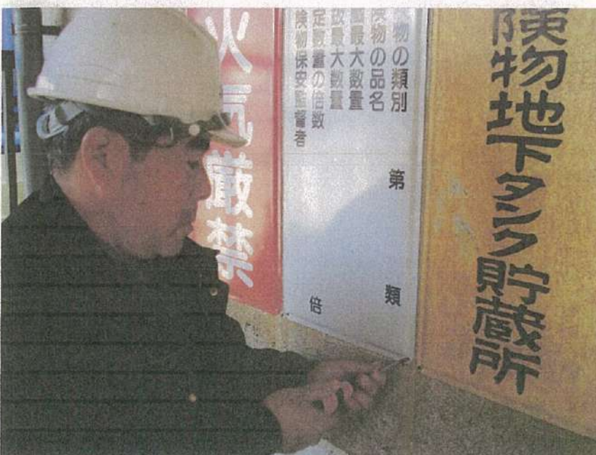
一般取扱所工事 表示看板新設 取替え状況
