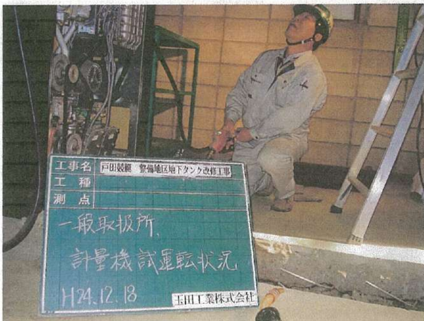
一般取扱所工事 計量機試運転状況
