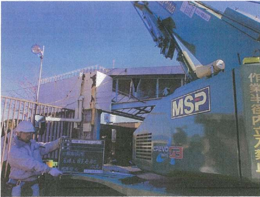
一般取扱所工事 屋根上換気塔 撤去工事 ラフター設置
