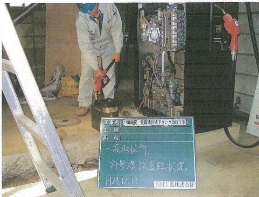
一般取扱所工事 計量機試運転状況
