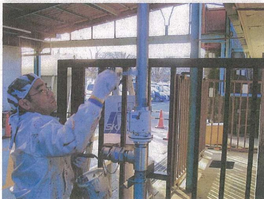
地下タンク設置工事 塗装工事 通気管塗布状況
