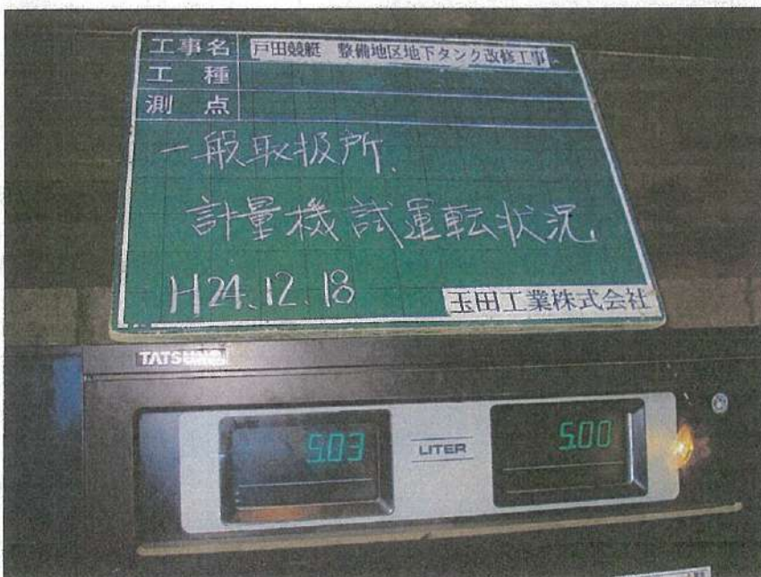
一般取扱所工事 計量機試運転完了 No.1、No.2 5リッター油だし
