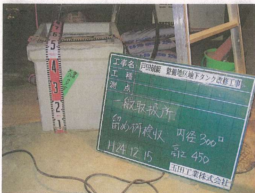
一般取扱所工事 強制換気交換工事 溜め枳検収 内径 300 \times 300 H=450
