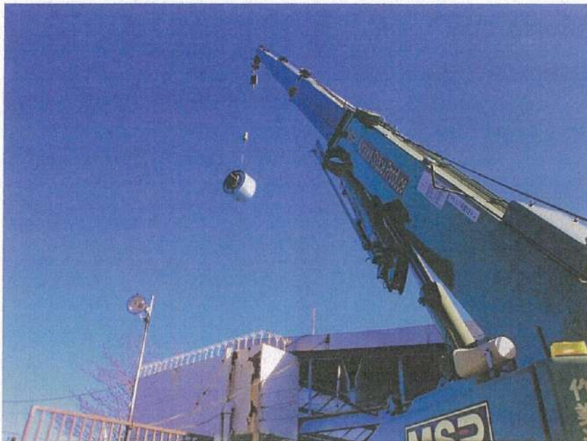
一般取扱所工事 屋根上換気塔 撤去工事 換気塔吊上げ状況
