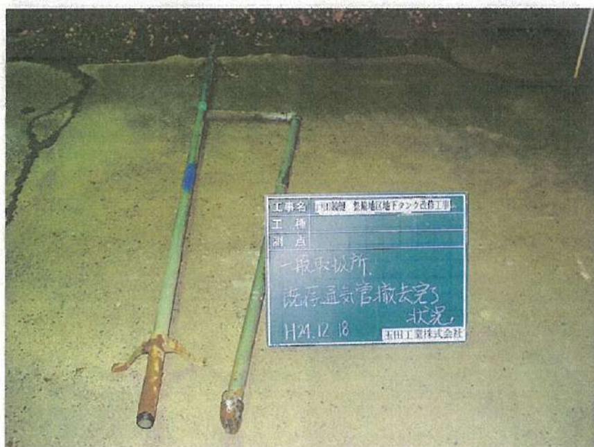
一般取扱所工事 解体工事 既存通気管 撤去完了状況
