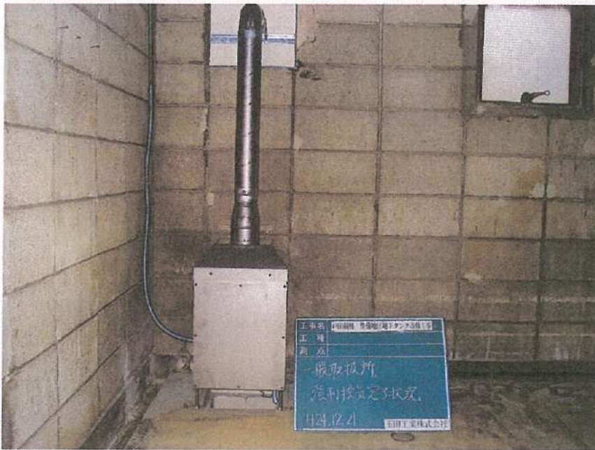
一般取扱所工事 強制換気交換工事 完了状況 内部
