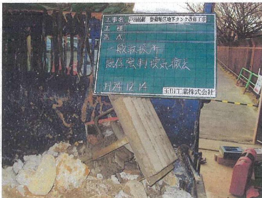
一般取扱所工事 強制換気交換工事 既存強制換気撤去
