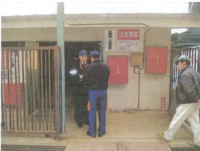
一般取扱所工事 消防検査 完了検査状況
