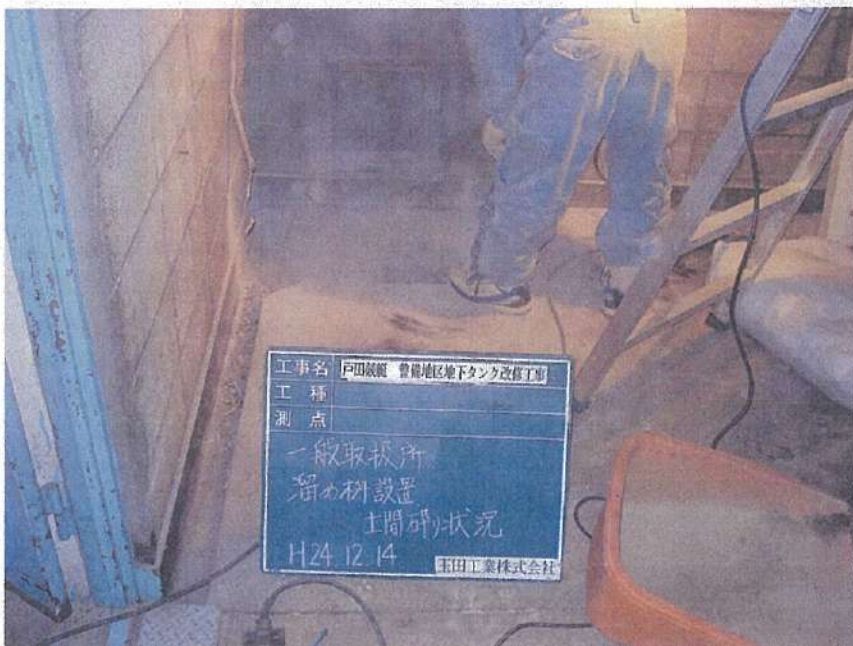
一般取扱所工事 強制換気交換工事 溜め桝新設 土間砕り状況
