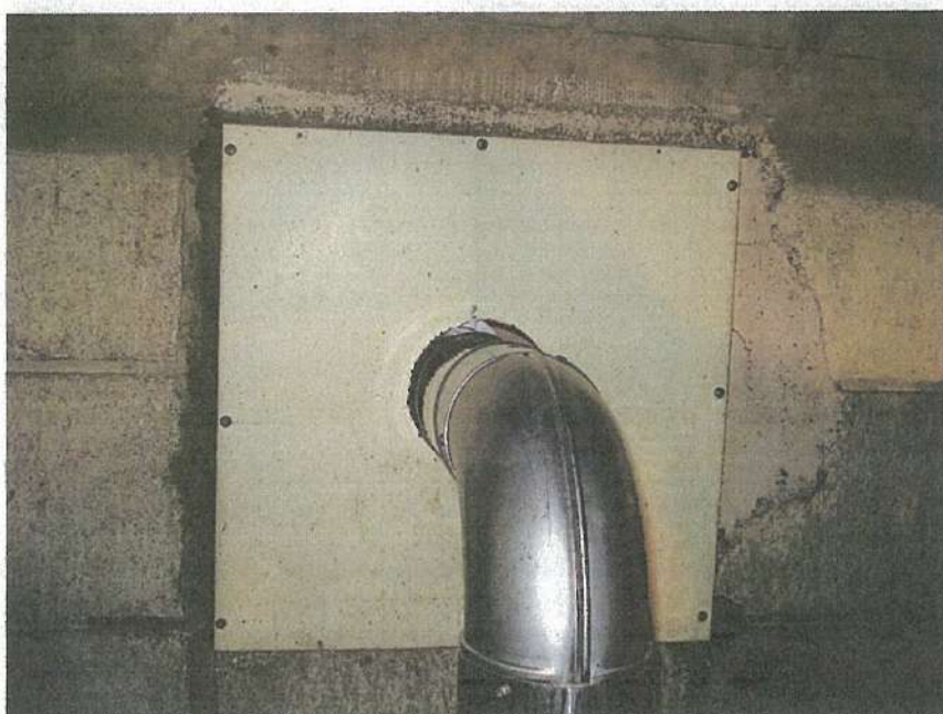
一般取扱所工事 強制換気交換工事 スパイラル管 100φ 内部貫通部
