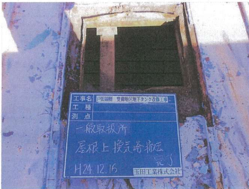
一般取扱所工事 屋根上換気塔 撤去工事 換気塔撤去完了状況
