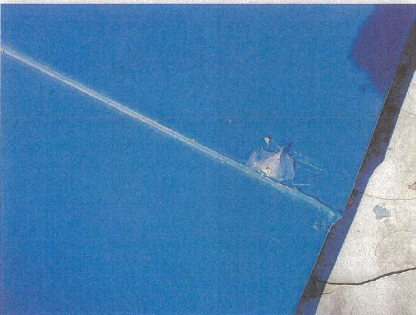
一般取扱所工事 屋根上換気塔 撤去工事 屋根復旧状況 ビス頭シーリング
