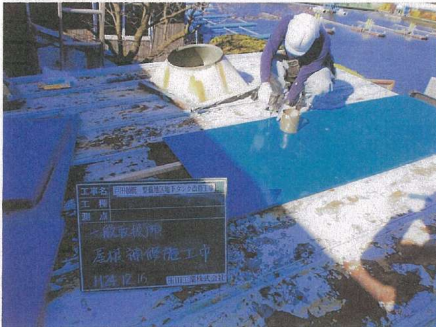
一般取扱所工事 屋根上換気塔 撤去工事 屋根復旧状況 屋根材張り
