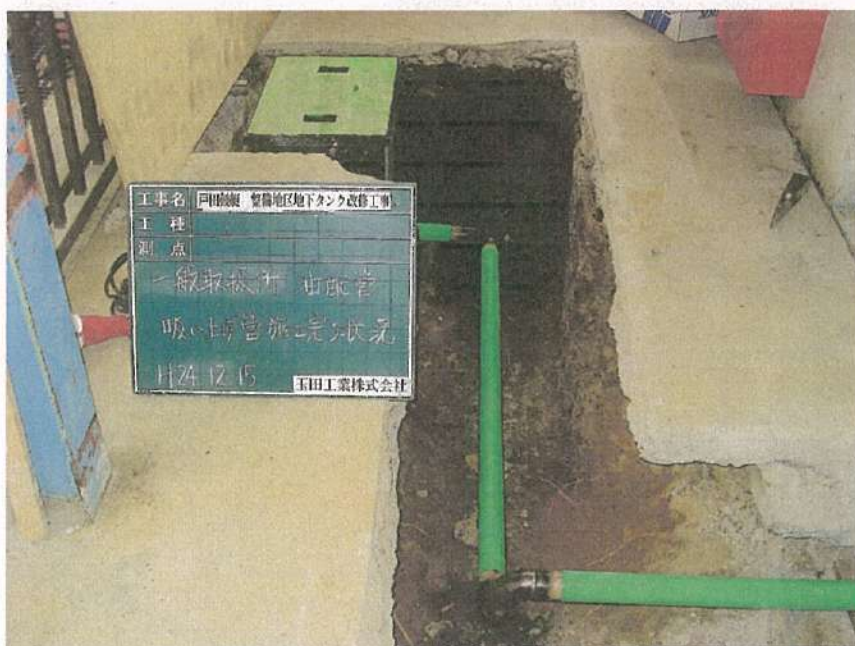
一般取扱所工事 油配管工事 吸上げ管完了状況
