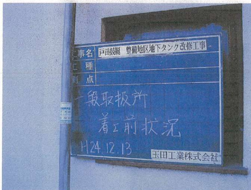
一般取扱所工事 着工前状況 通気管
