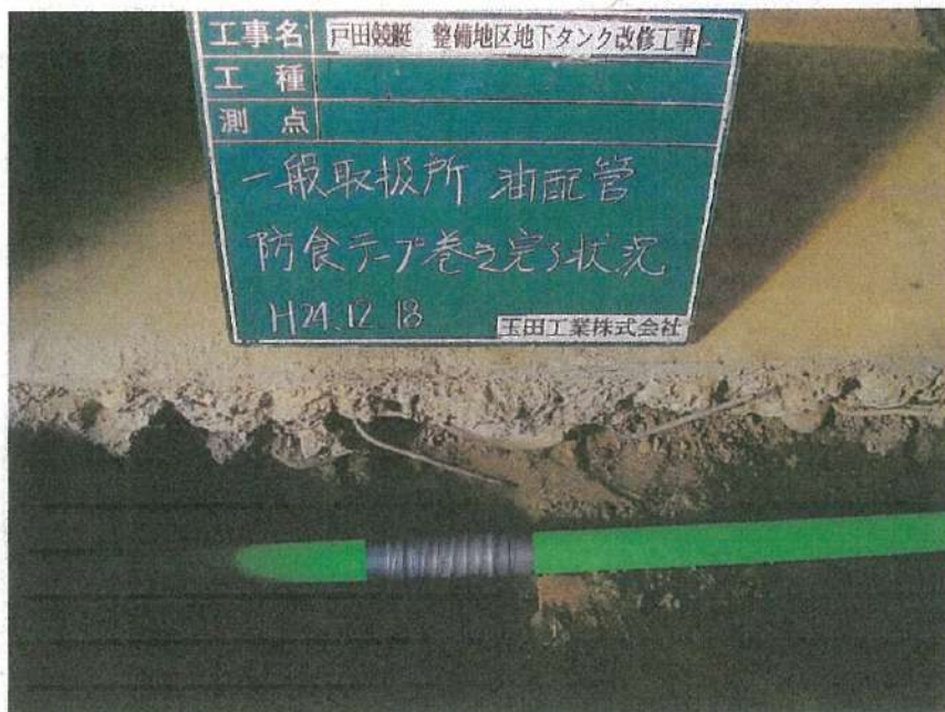
一般取扱所工事 油配管工事 SGP管 吸上げ管防食 防食テープ巻き完了状況
