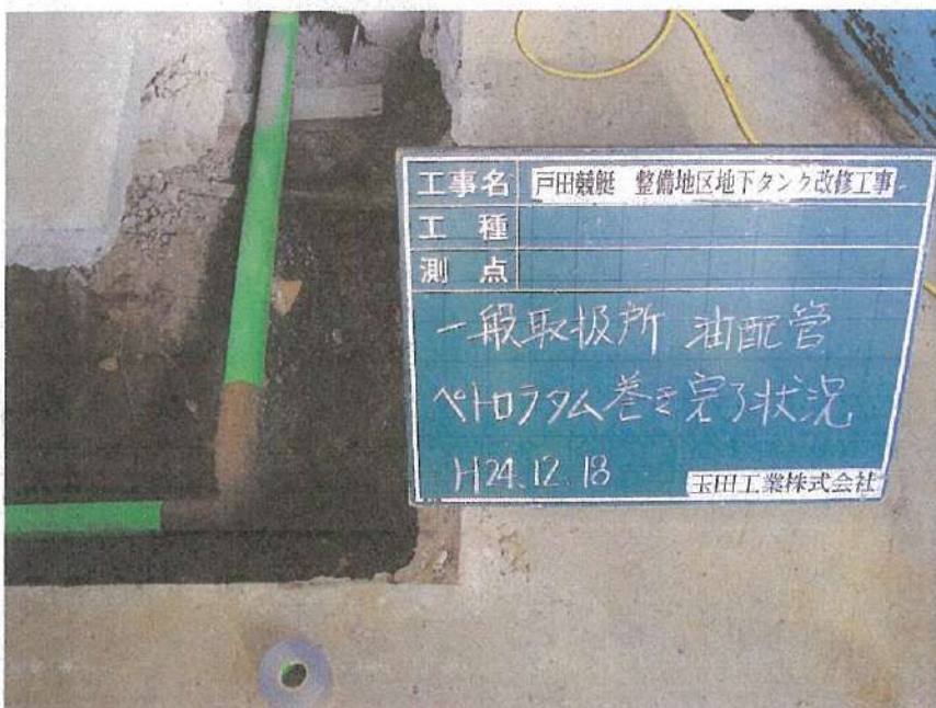
一般取扱所工事 油配管工事 SGP管 吸上げ管防食 ペトロラタム巻き完了状況
