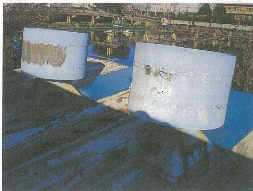
一般取扱所工事 着工前状況 屋根上全景
