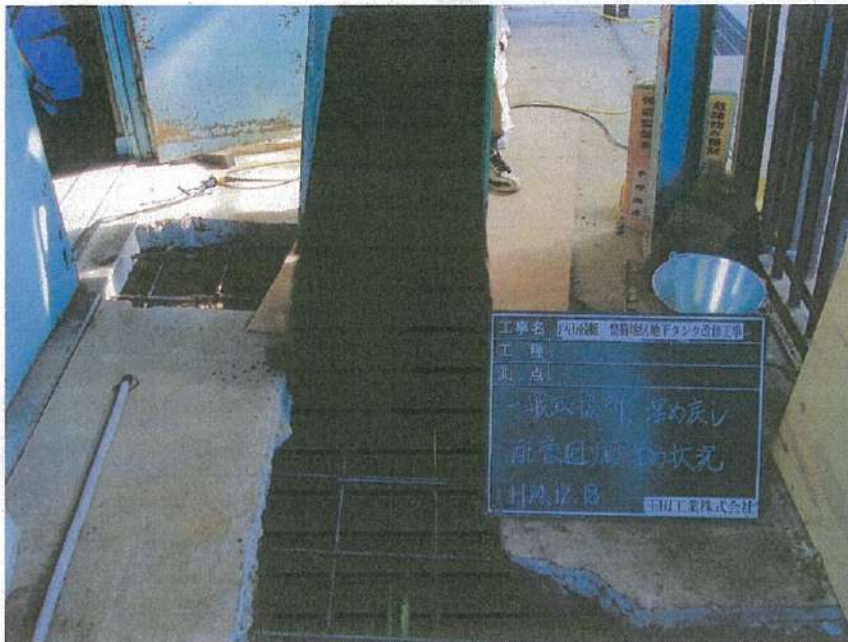
一般取扱所工事 土工事 配管周り 砂埋め戻し状況
