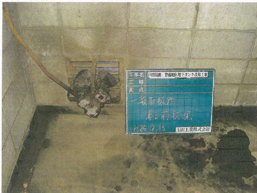
一般取扱所工事 着工前状況 内部強制換気
