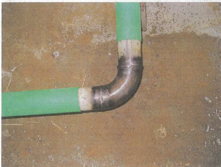
一般取扱所工事 油配管工事 吸上げ管溶接部
