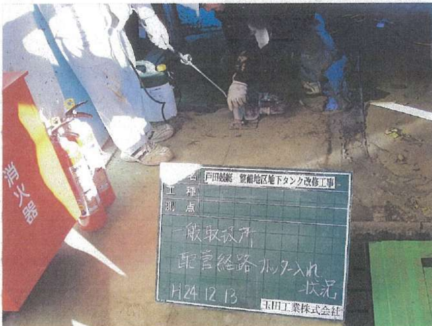
一般取扱所工事 解体工事 配管経路カッター入れ状況
