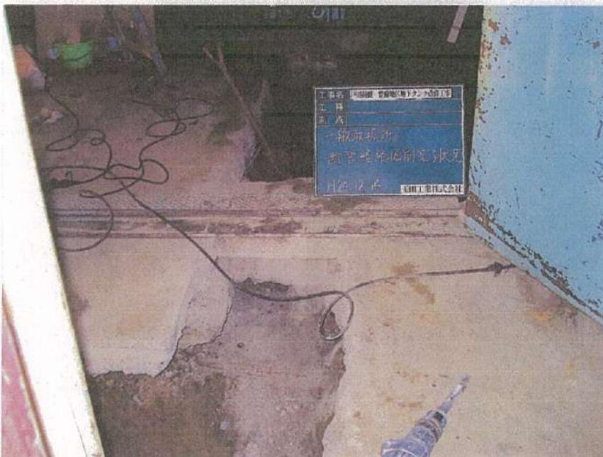
一般取扱所工事 解体工事 配管経路 掘削完了状況
