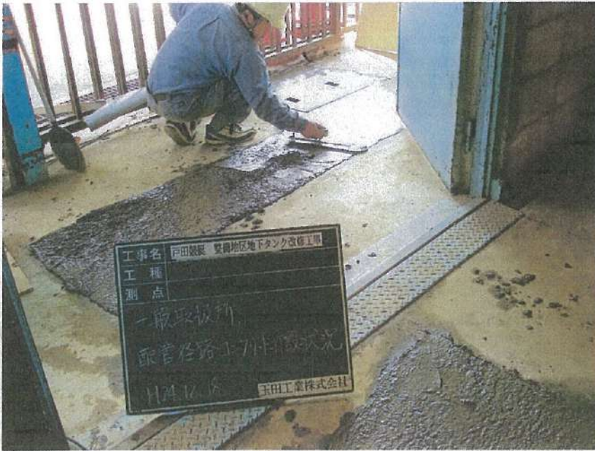
一般取扱所工事 コンクリート工事 配管経路打設状況
