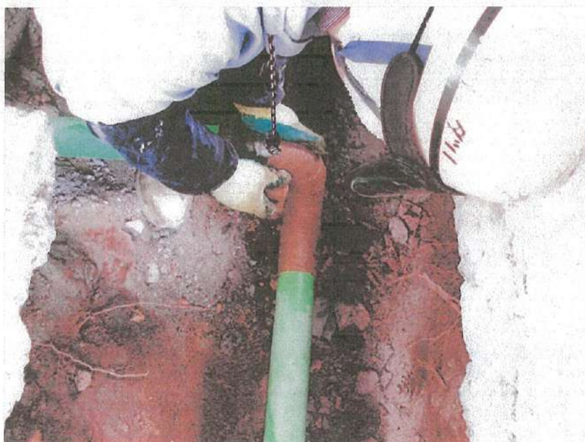
一般取扱所工事 油配管工事 SGP管 吸上げ管防食 ペトロラタム巻き状況
