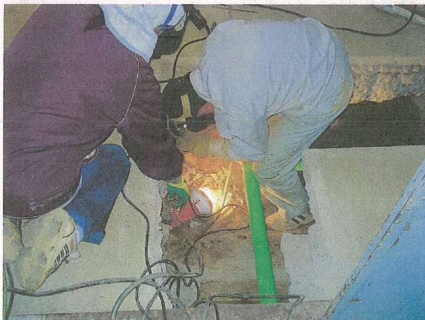
一般取扱所工事 油配管工事 吸上げ管溶接状況
