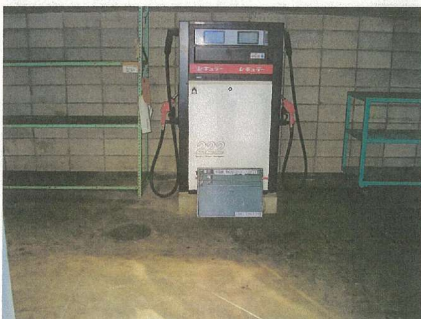
一般取扱所工事 着工前状況 内部全景
