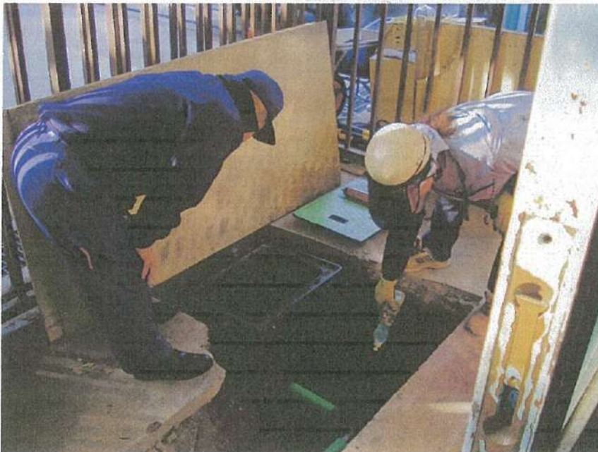
一般取扱所工事 消防検査 発砲検査状況
