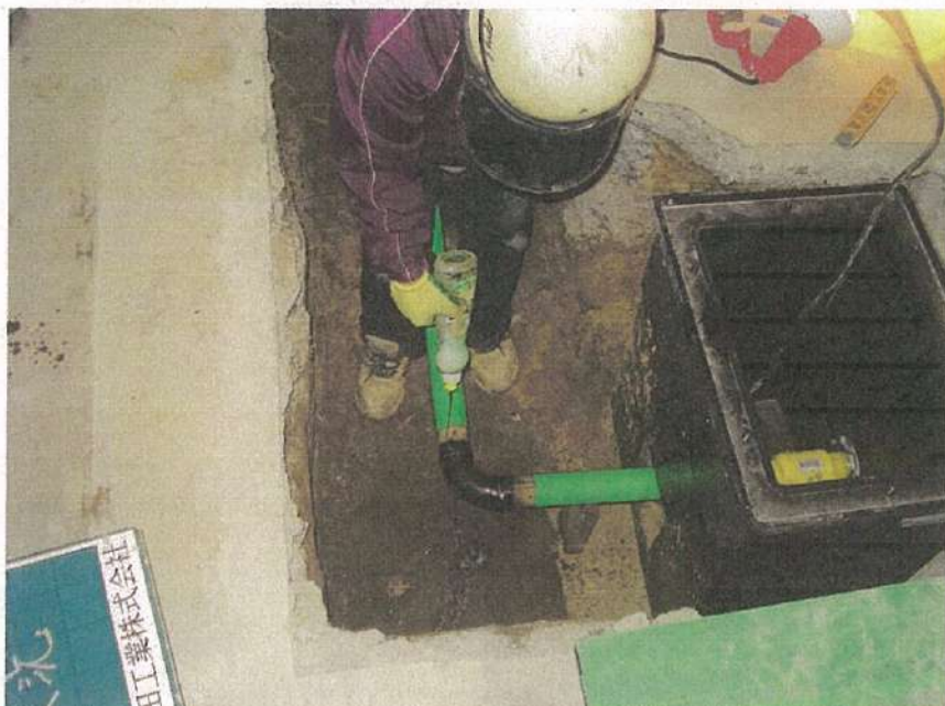
一般取扱所工事 油配管工事 自主検査 発砲検査状況
