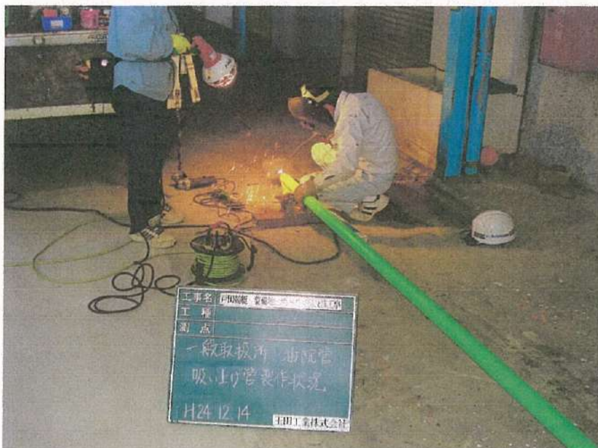
一般取扱所工事 油配管工事 吸上げ管製作状況 溶接
