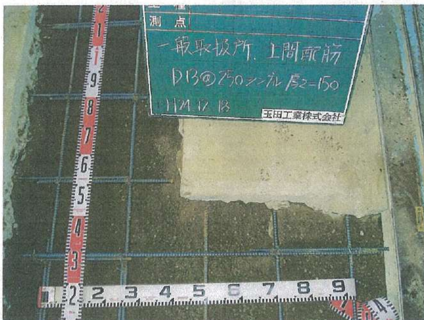
一般取扱所工事 鉄筋工事 配管経路土間 D13@250(タテ、ヨコ共) シングル 厚さ=150
