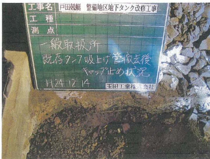
一般取扱所工事 油配管工事 既存タンク吸上げ管 撤去後 キャップ閉管状況
