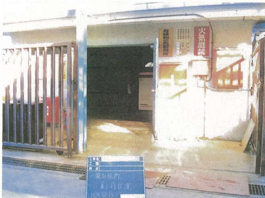
一般取扱所工事 着工前状況 正面全景
