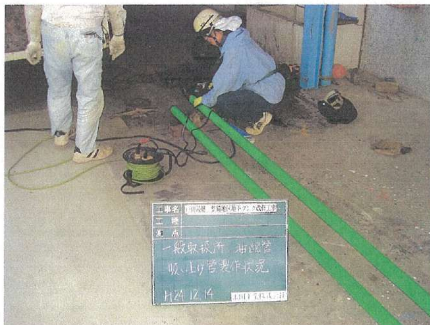
一般取扱所工事 油配管工事 吸上げ管製作状況 溶接部研磨
