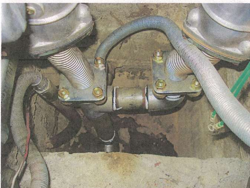
一般取扱所工事 油配管工事 計量機配管接続 完了状況
