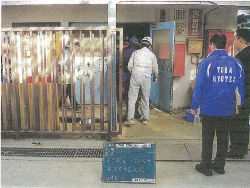
一般取扱所工事 消防検査 油配管検査状況
