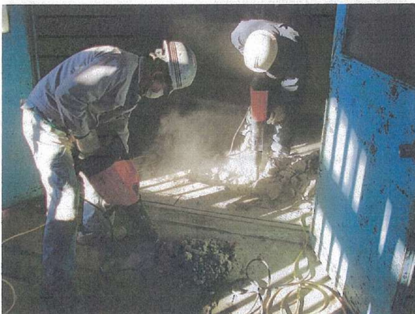
一般取扱所工事 解体工事 配管経路砕り状況
