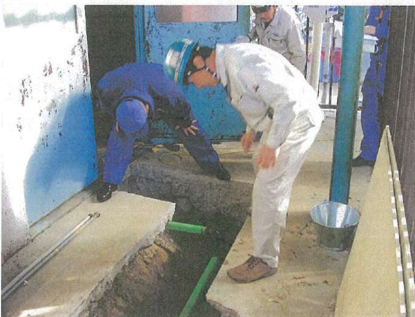
一般取扱所工事 消防検査 油配管検査状況
