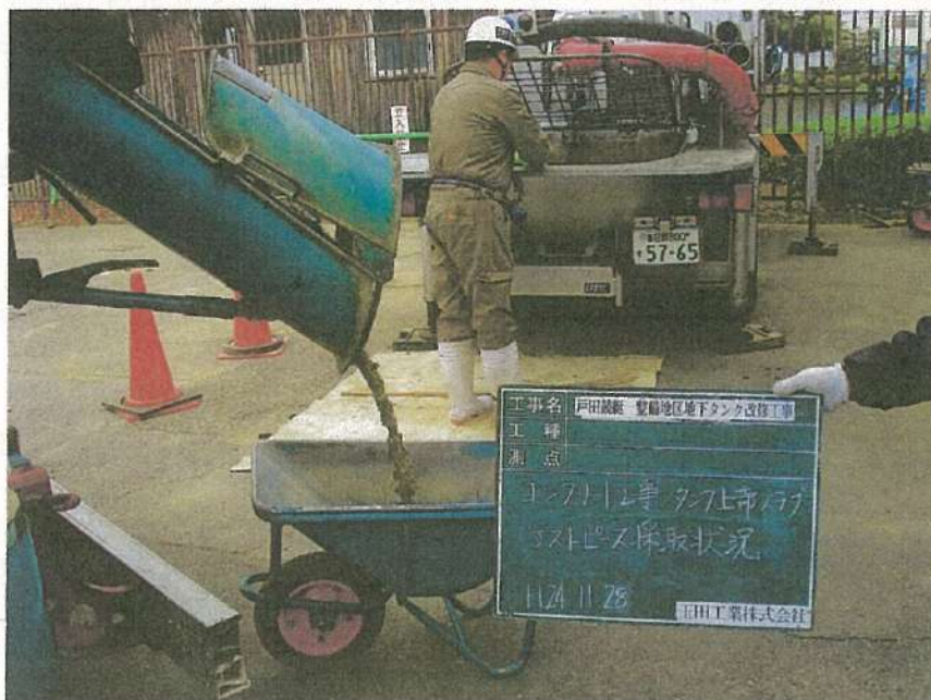
地下タンク設置工事 コンクリート工事 タンク上部スラブ テストピース採取状況
