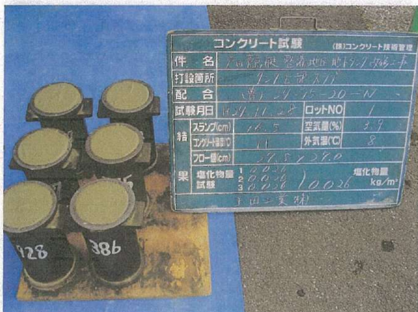
地下タンク設置工事 コンクリート工事 タンク上部スラブ テストピース状況
