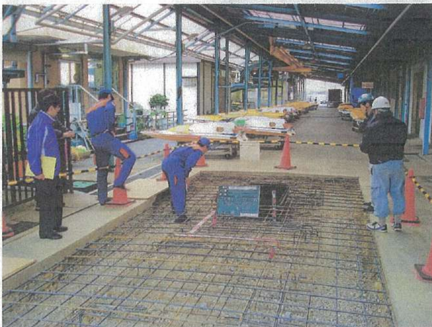
地下タンク設置工事 消防検査状況 タンク上部スラブ配筋 D13@250(タテ・ヨコ共) ダブル 厚さ=300
