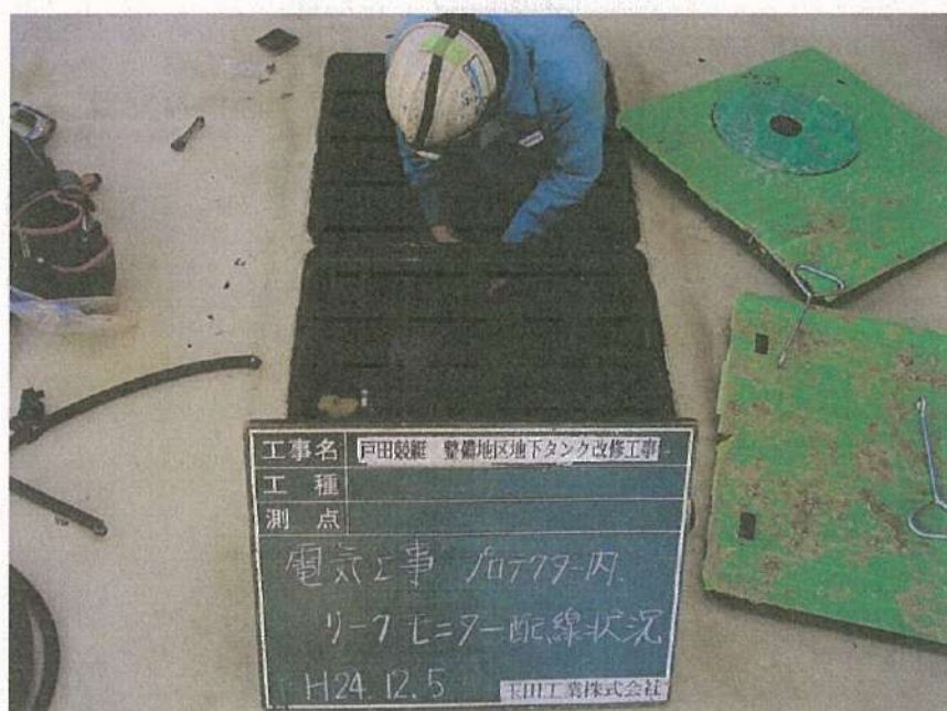
地下タンク設置工事 プロテクター内機器取付 リークモニター 配線状況
