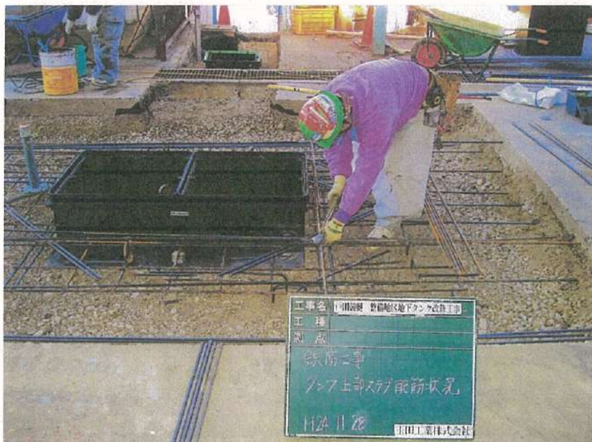
地下タンク設置工事 鉄筋工事 タンク上部スラブ配筋 D13@250(タテ・ヨコ共) ダブル 厚さ=300 配筋状況
