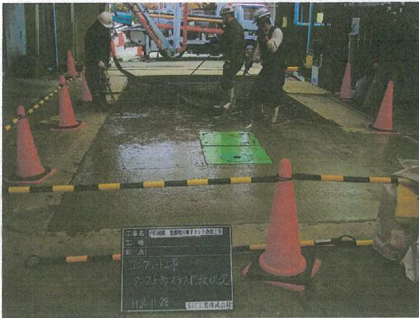
地下タンク設置工事 コンクリート工事 タンク上部スラブ 打設状況
