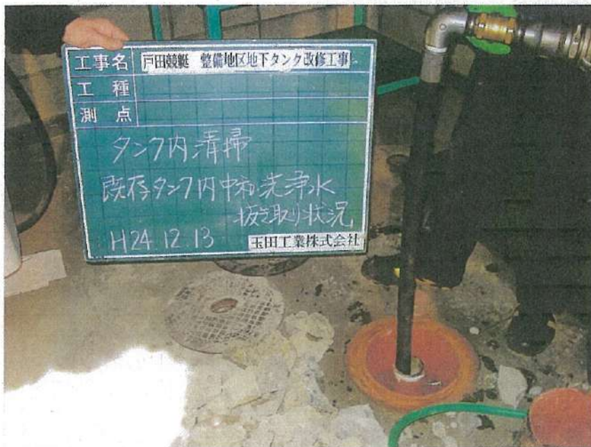
一般取扱所工事 既存タンク工事 中和洗浄水 抜き取り状況
