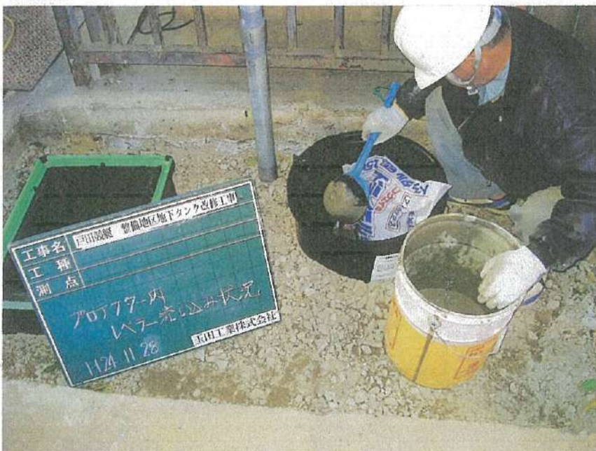
地下タンク設置工事 遠方注油口内部 レベラー流し込み状況
