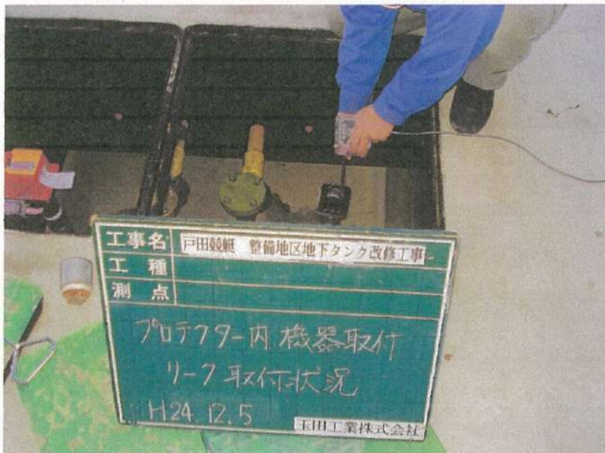
地下タンク設置工事 プロテクター内機器取付 リークモニター 取付状況
