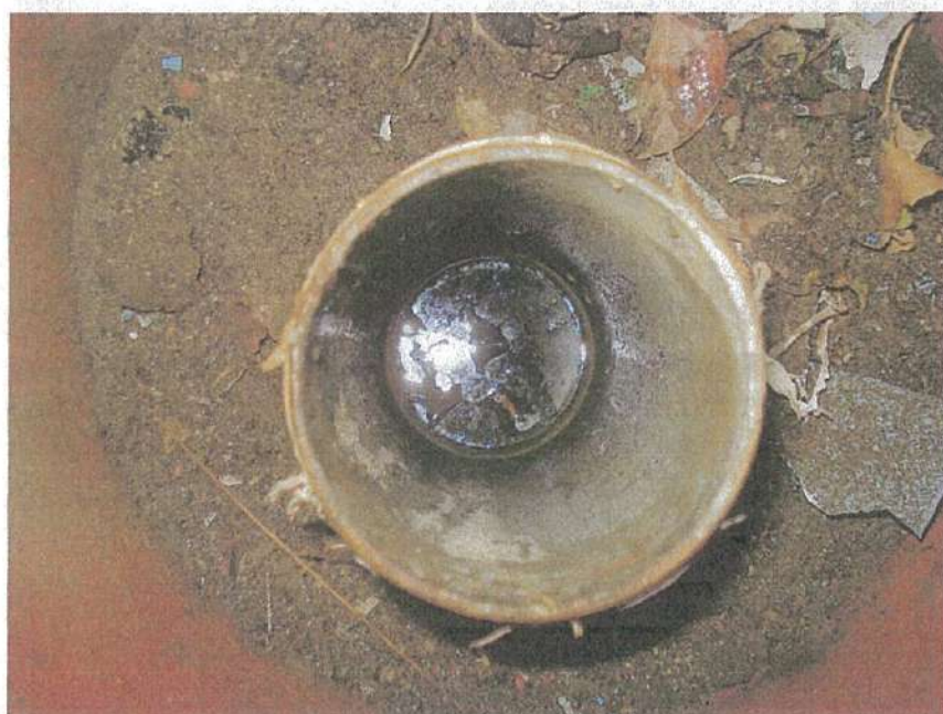
一般取扱所工事 既存タンク 水入れ完了状況
