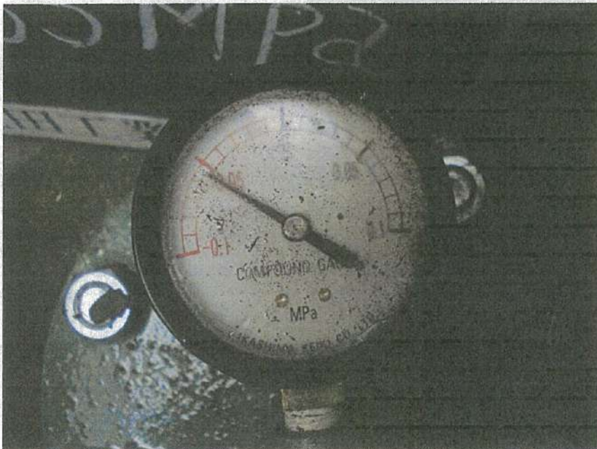
地下タンク設置工事 プロテクター内機器取付 タンク内減圧ゲージ撤去前 (0.055MPa)
