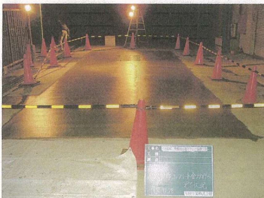
地下タンク設置工事 コンクリート工事 タンク上部スラブ 金型押さえ完了状況
