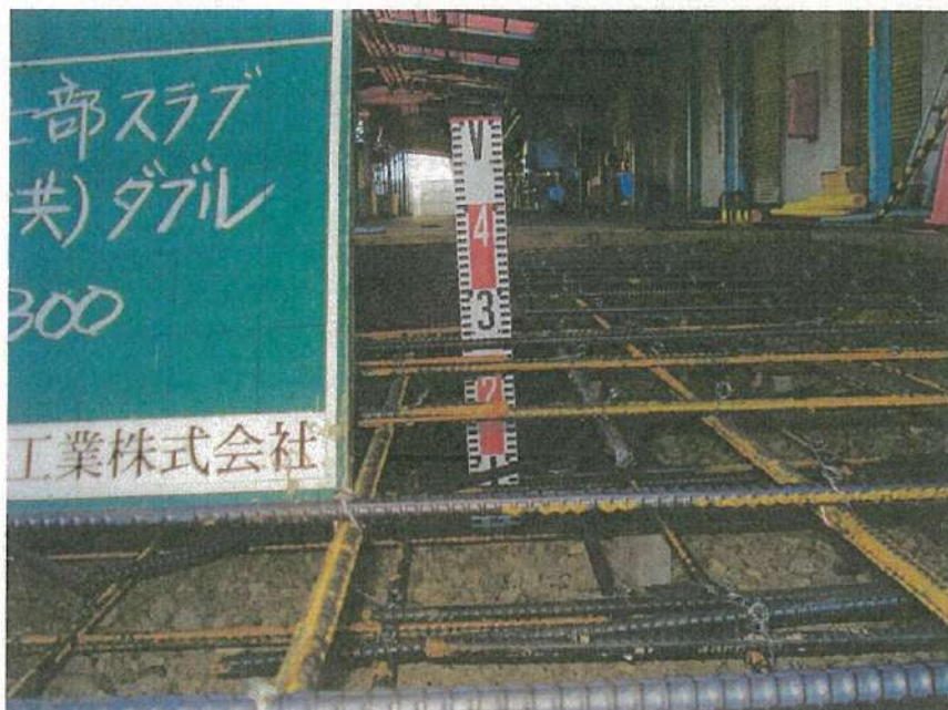
地下タンク設置工事 鉄筋工事 タンク上部スラブ配筋 D13@250(タテ・ヨコ共) ダブル 厚さ=300 配筋完了状況
