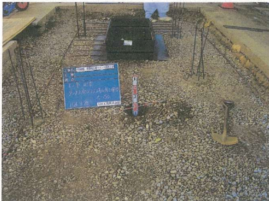
地下タンク設置工事 地業 タンク上部 碎石厚さ確認 t = 150
