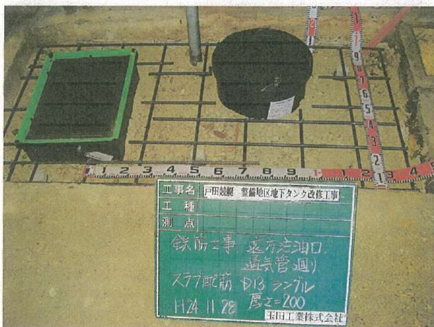
地下タンク設置工事 鉄筋工事 遠方注油口・通気管 スラブ配筋 D13@200(タテ・ヨコ共) シングル 厚さ=200 配筋完了状況
