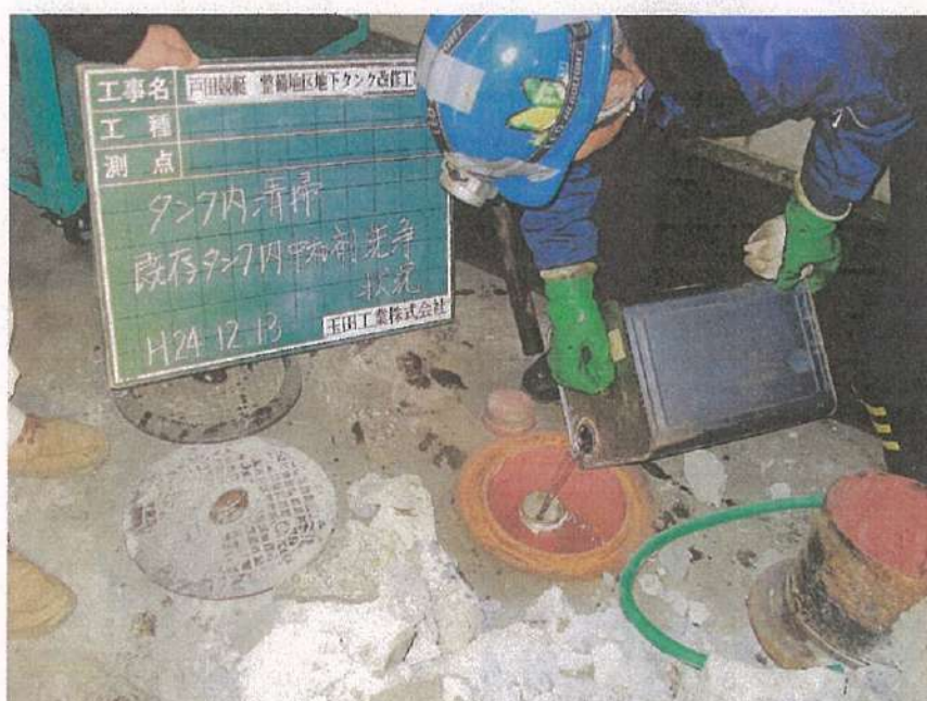
一般取扱所工事 既存タンク工事 中和剤注入状況 品名：エコクラウン
