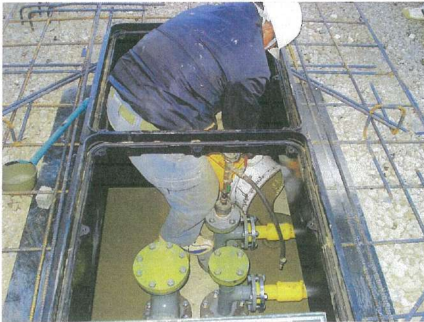
地下タンク設置工事 プロテクター内部 レベラー流し込み状況
