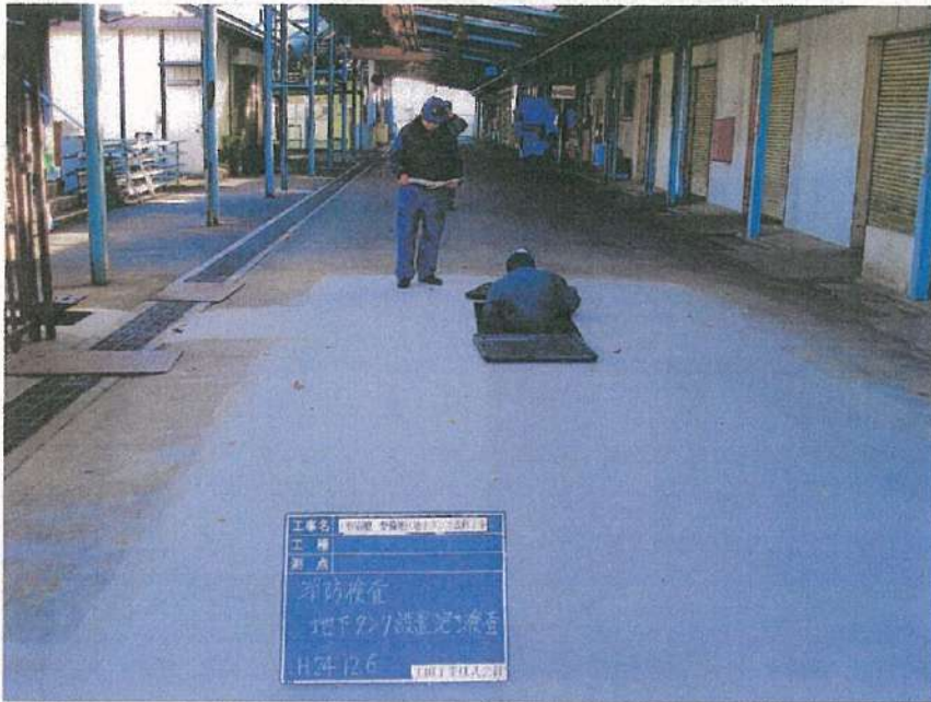
地下タンク設置工事 消防完了検査状況
