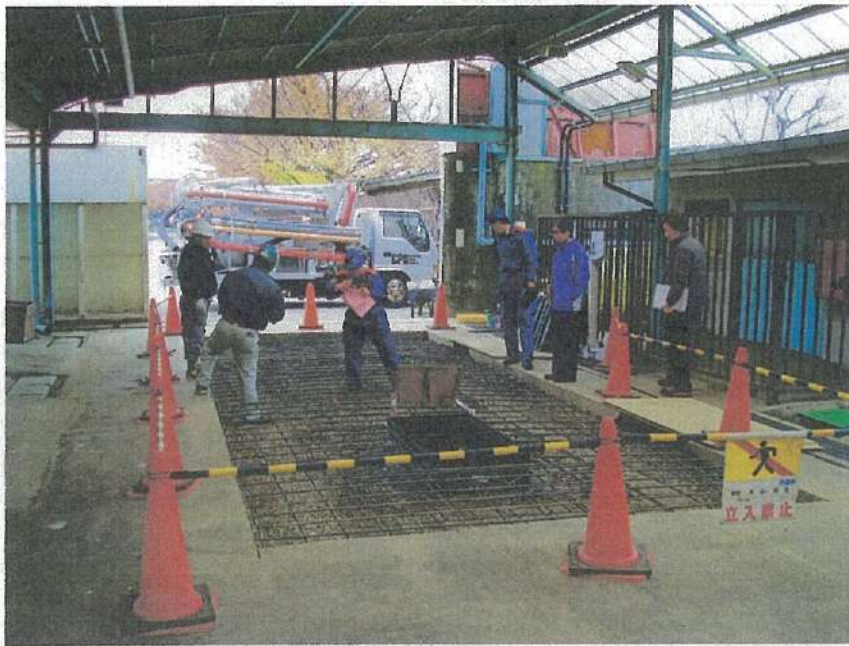
地下タンク設置工事 消防検査状況 タンク上部スラブ配筋 D13@250(タテ・ヨコ共) ダブル 厚さ=300
