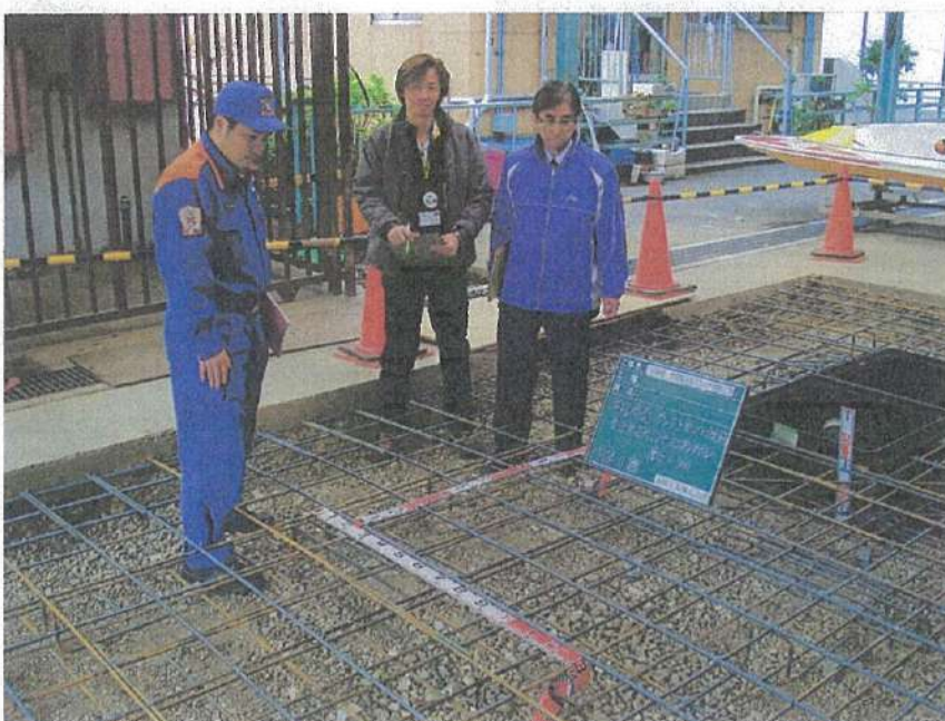
地下タンク設置工事 施主立会い タンク上部スラブ配筋 D13@250(タテ・ヨコ共) ダブル 厚さ=300
