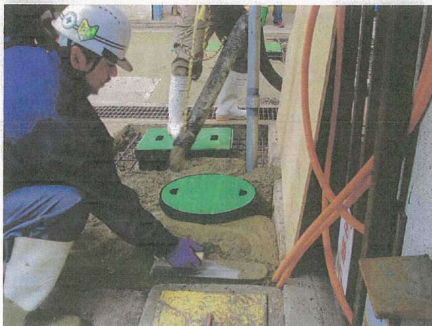
地下タンク設置工事 コンクリート工事 遠方注油口周り 打設状況
