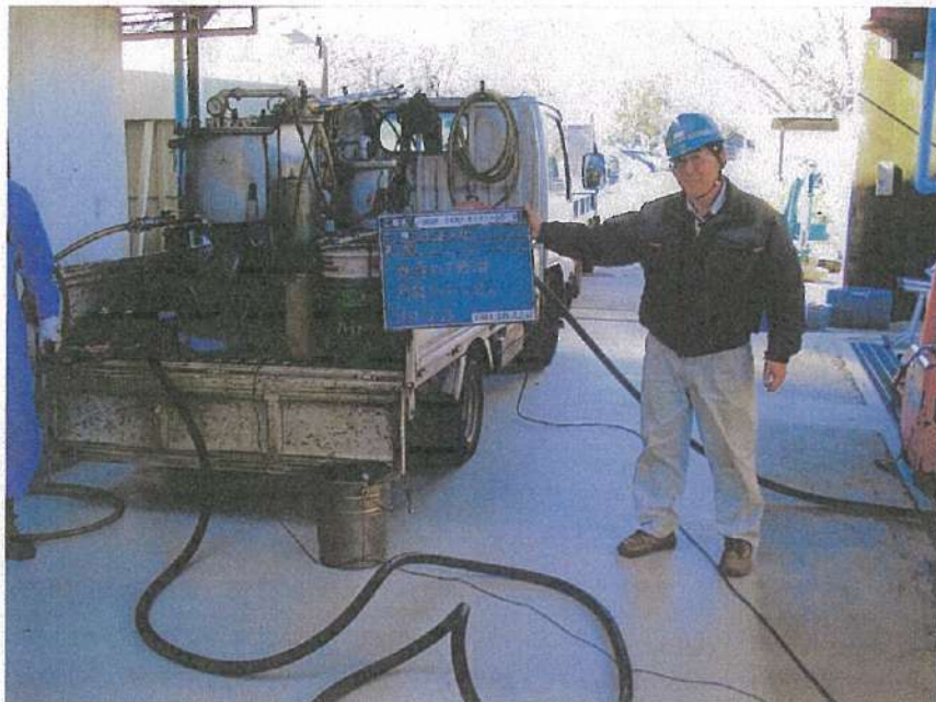
一般取扱所工事 残油シフト 既存タンク残油 新設タンクへ注入
