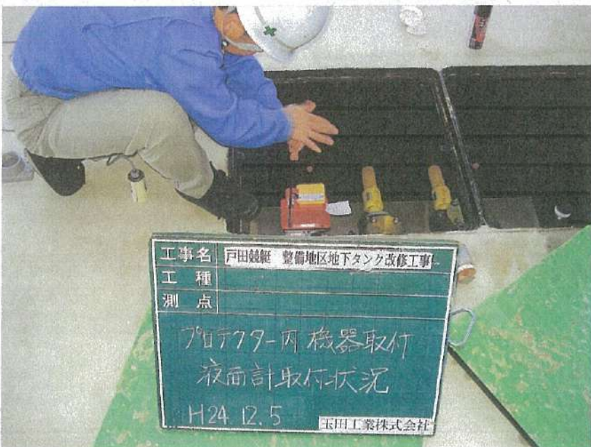
地下タンク設置工事 プロテクター内機器取付 液面計取付状況
