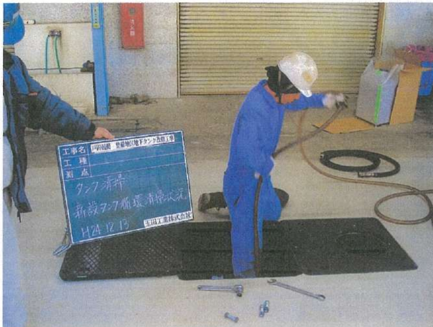
一般取扱所工事 タンク清掃工事 新設タンク内 循環清掃状況
