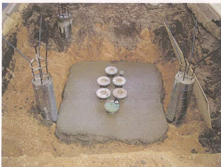
地下タンク設置工事 コンクリート工事 プロテクター捨てコン 打設完了状況
