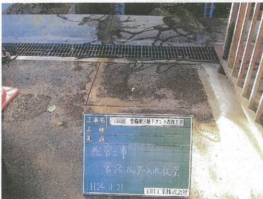
地下タンク設置工事 配管工事 遠方注油口・通気管 配管経路カッター入れ状況
