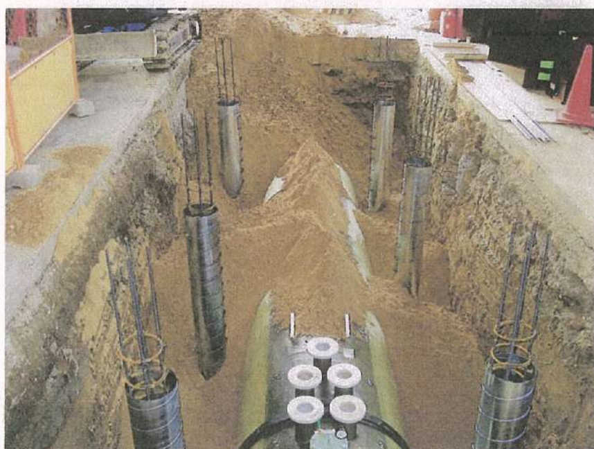
地下タンク設置工事 土工事 タンク周り砂埋め戻し状況
