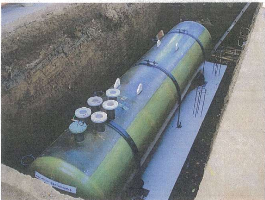
地下タンク設置工事 SF二重殻・6Kタンク 現場設置 完了状況
