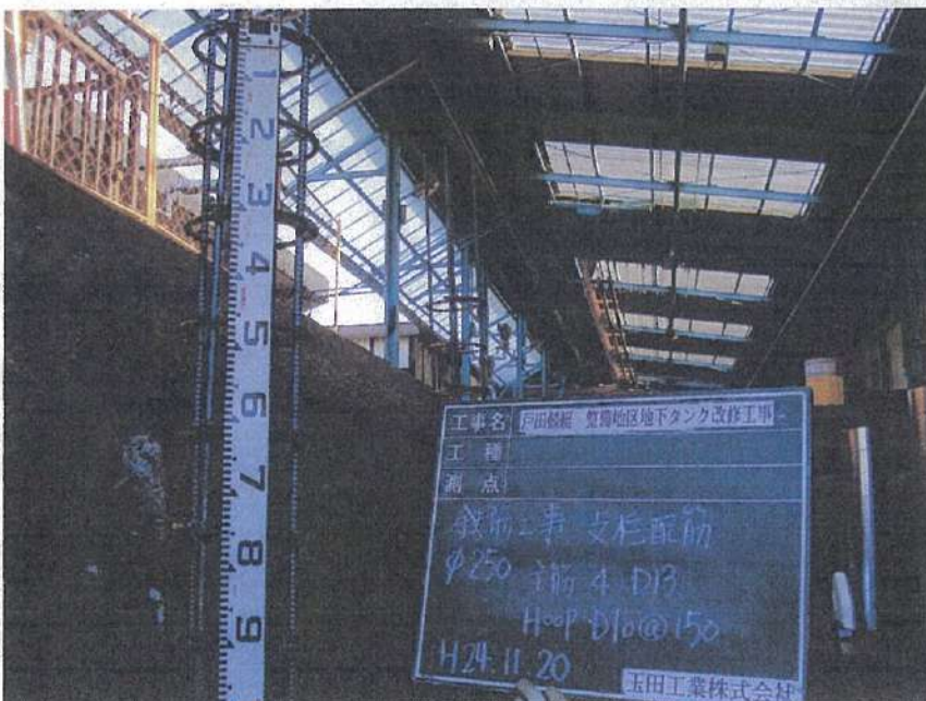
地下タンク設置工事 鉄筋工事 支柱配筋 \Phi 250 主筋 4-D13 HOOP D10@150
