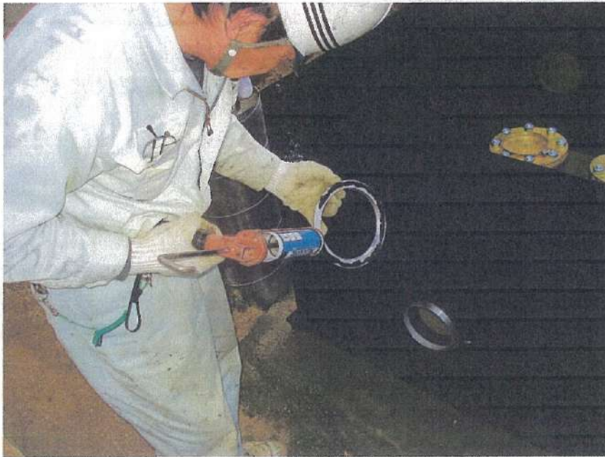
地下タンク設置工事 油配管 タンク上部配管 プロテクター貫通部 配管ソケット取付 シーリング打設状況
