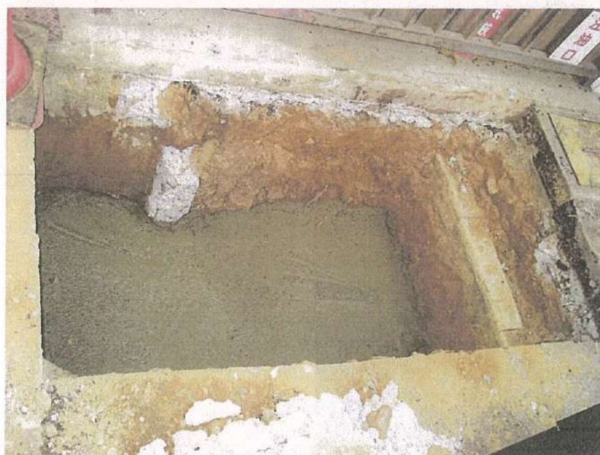
地下タンク設置工事 コンクリート工事 遠方注油口・通気管 捨てコン打設完了状況
