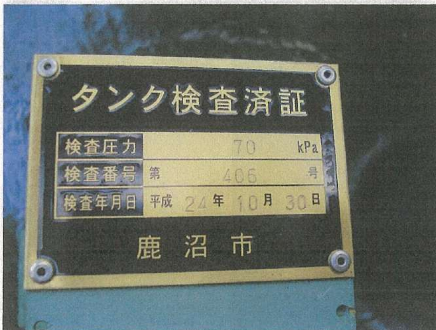
地下タンク設置工事 SF二重殻・6Kタンク タンク検査済証
