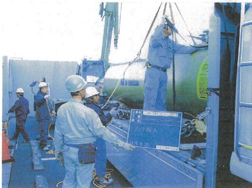
地下タンク設置工事 SF二重殻・6Kタンク 搬入
