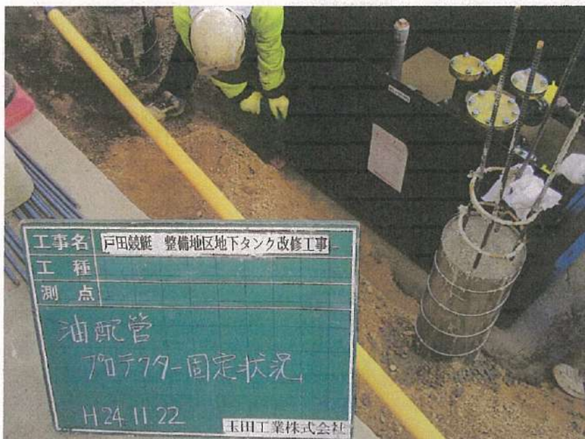
地下タンク設置工事 油配管 タンク上部配管 プロテクター固定状況
