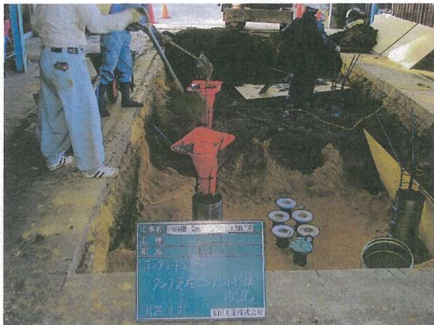
地下タンク設置工事 コンクリート工事 支柱打設状況
