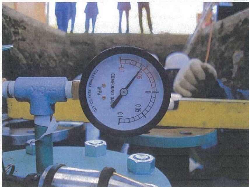
地下タンク設置工事 SF二重殻・6Kタンク 現場設置 タンク内減圧ゲージ 確認(0.055MPa)
