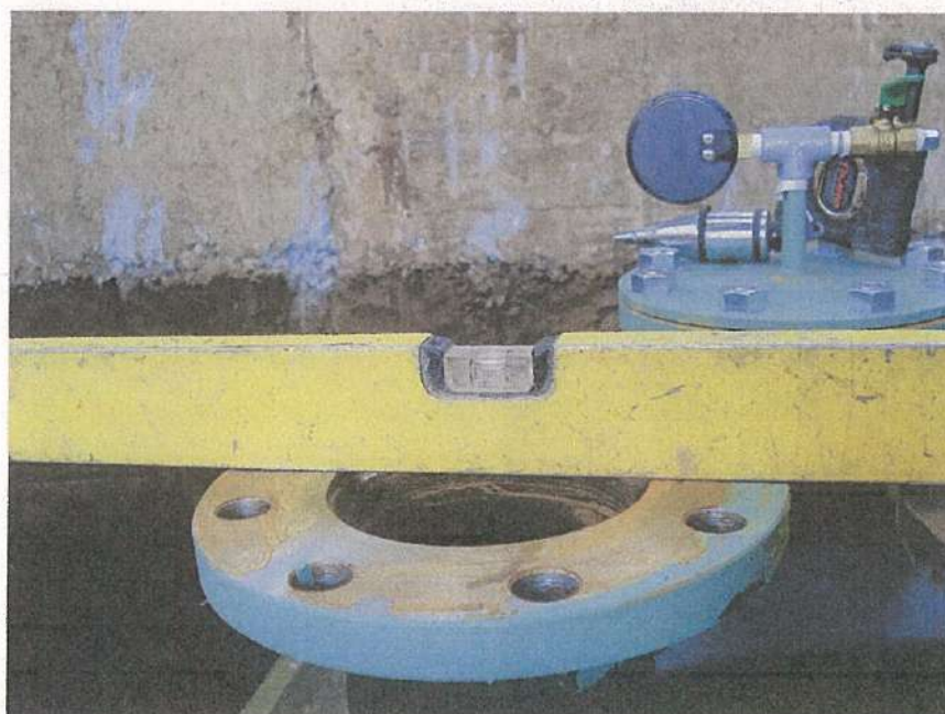
地下タンク設置工事 SF二重殻・6Kタンク 現場設置 水平確認状況
