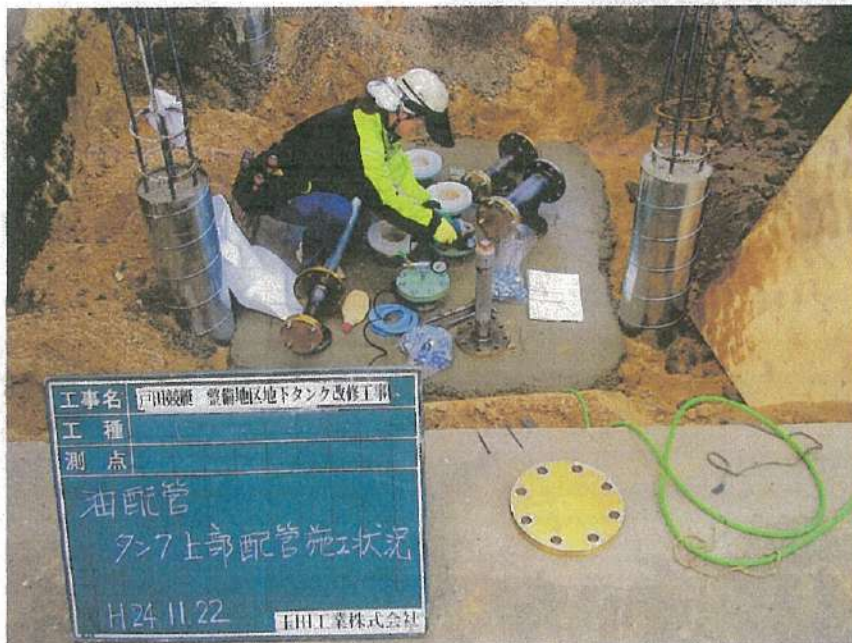
地下タンク設置工事 油配管 タンク 上部配管状況
