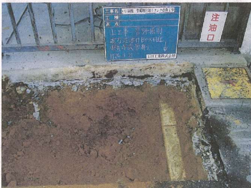
地下タンク設置工事 配管工事 遠方注油口・通気管 配管経路掘削状況 電気埋設管BOX有り
