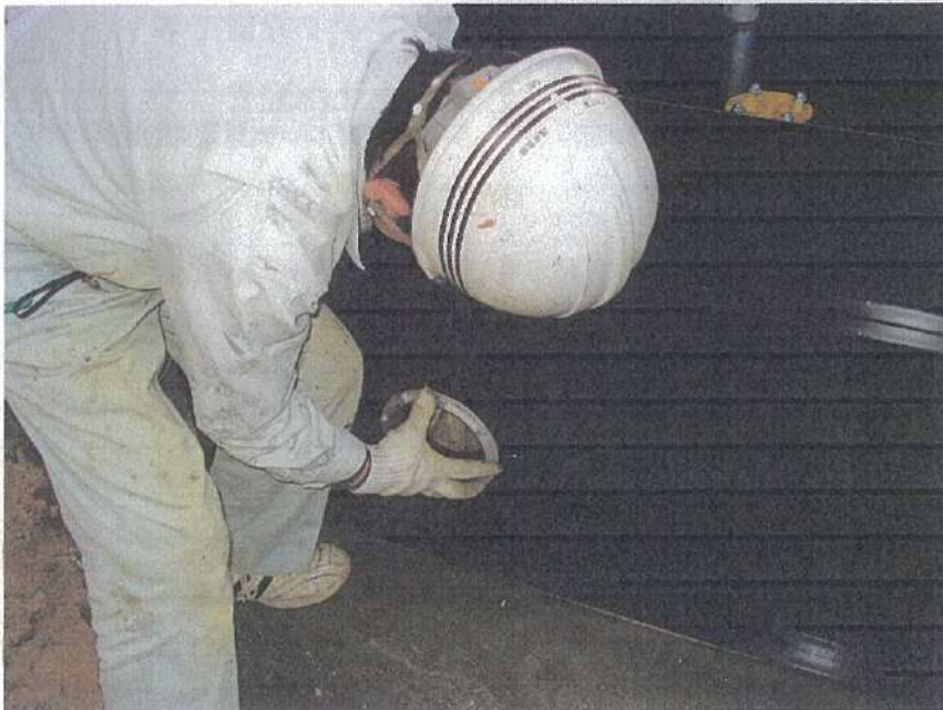
地下タンク設置工事 油配管 タンク上部配管 プロテクター貫通部 配管ソケット取付状況
