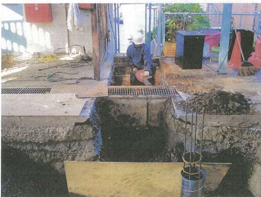
地下タンク設置工事 配管工事 遠方注油口・通気管 配管経路掘削状況 地中障害(梁)撤去状況
