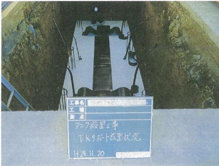
地下タンク設置工事 SF二重殻・6Kタンク TKサポート設置状況
