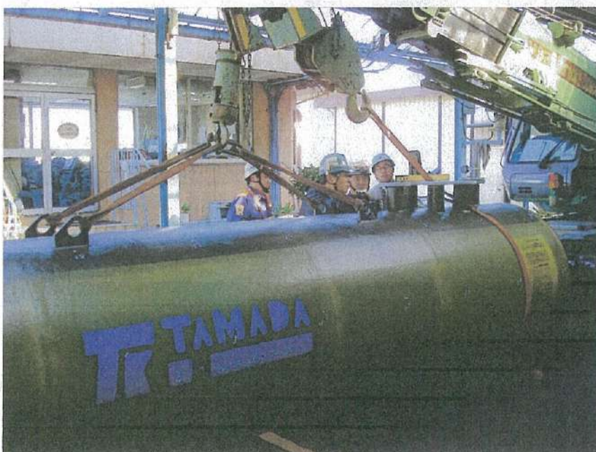
地下タンク設置工事 SF二重殻・6Kタンク ラフター玉掛け状況
