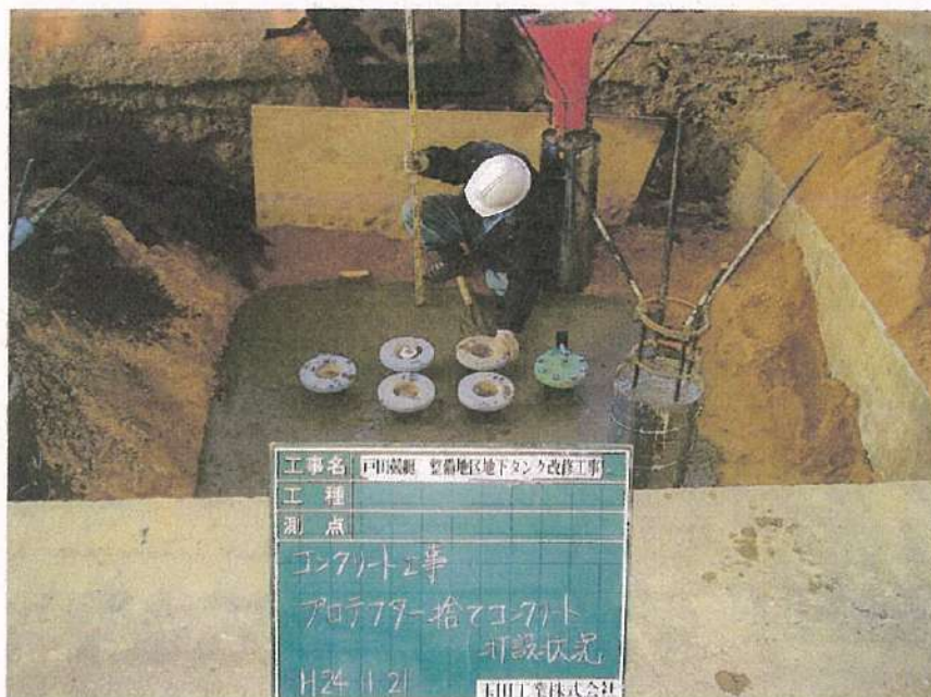
地下タンク設置工事 コンクリート工事 プロテクター捨てコン 打設状況
