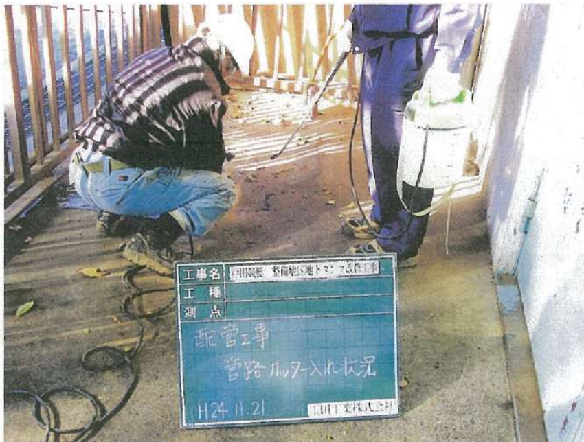
地下タンク設置工事 配管工事 吸上げ管 配管経路カッター入れ状況
