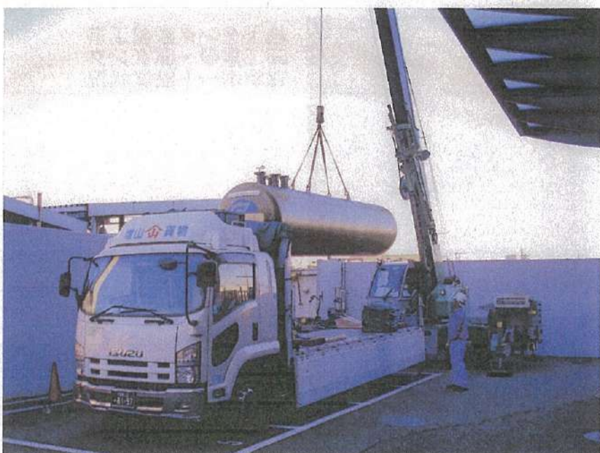
地下タンク設置工事 SF二重殻・6Kタンク 吊上げ状況
