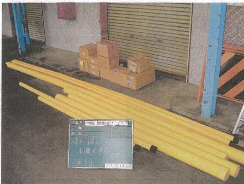
地下タンク設置工事 油配管工事 樹脂配管材、部材搬入 全景
