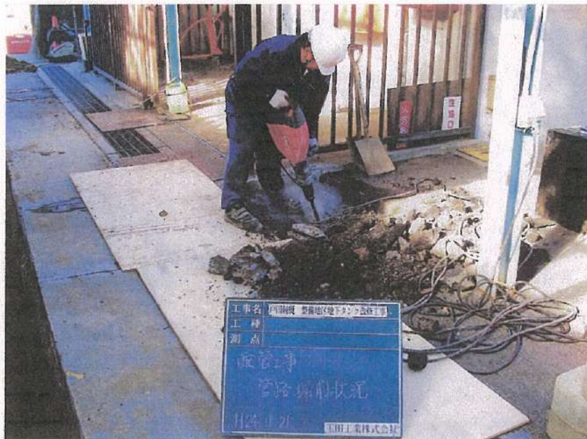
地下タンク設置工事 配管工事 遠方注油口・通気管 配管経路掘削状況
