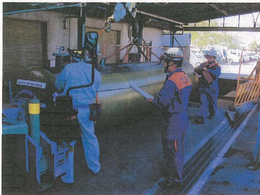
地下タンク設置工事 SF二重殻・6Kタンク 消防検査状況
