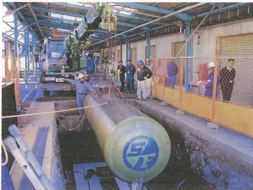
地下タンク設置工事 SF二重殻・6Kタンク 現場設置状況
