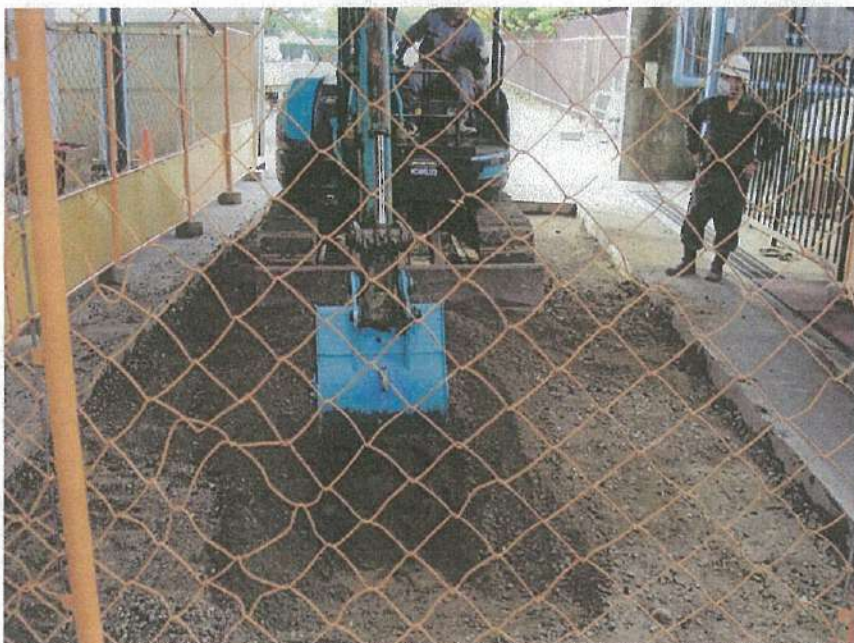
地下タンク設置工事 土工事 根伐 掘削状況
