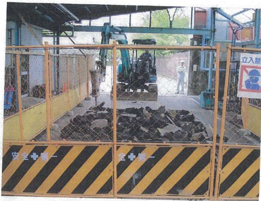
地下タンク設置工事 解体工事 舗装解体状況
