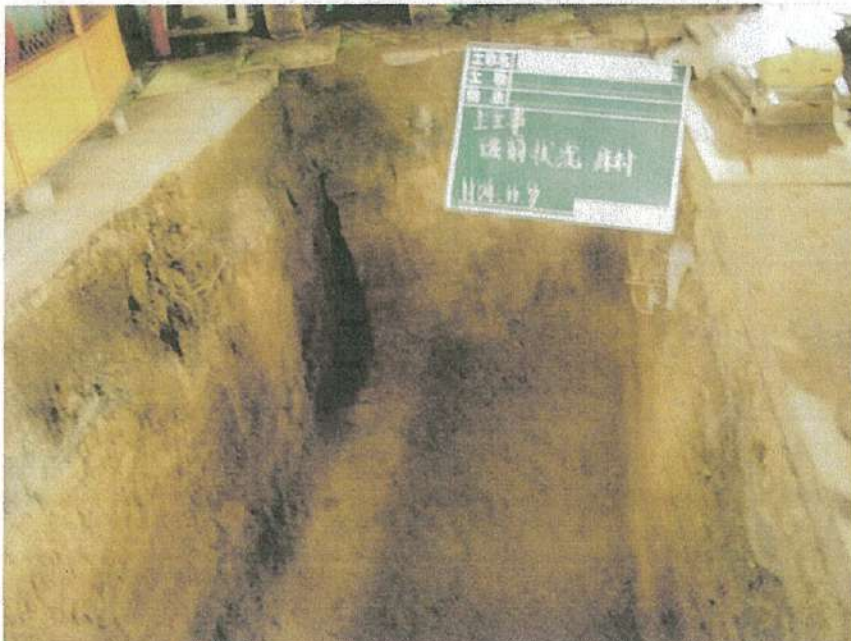
地下タンク設置工事 土工事 根伐 掘削 床付け状況
