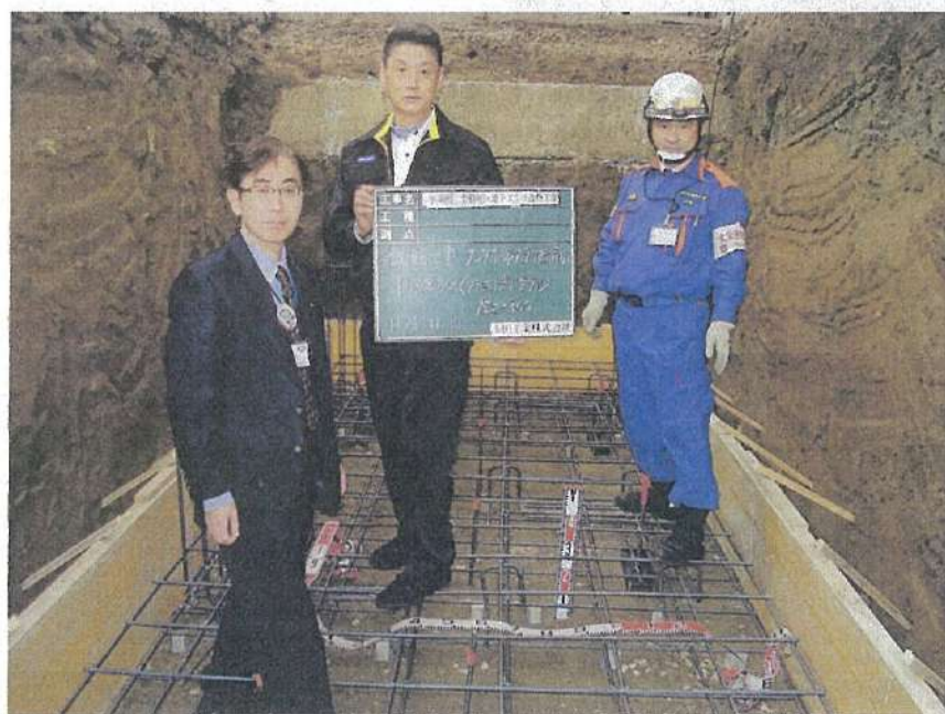
地下タンク設置工事 消防検査 タンク下部スラブ配筋検査 施主立会い D13@300 (タテ、ヨコ共) ダブル配筋 厚さ=300
