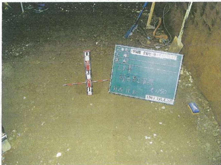
地下タンク設置工事 土工事 地業 碎石厚さ確認 t = 150
