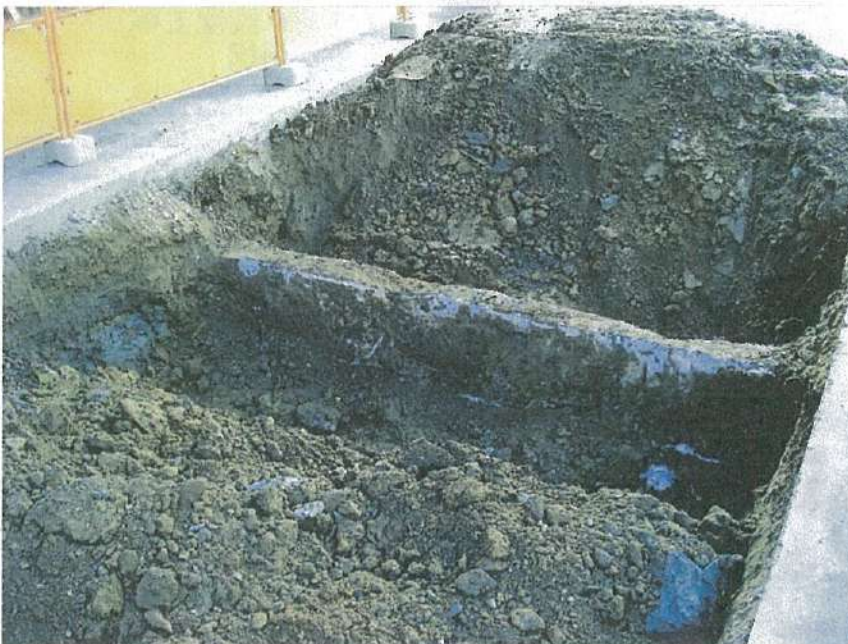
地下タンク設置工事 土工事 掘削 地中障害(地中梁) H=500、W=150
