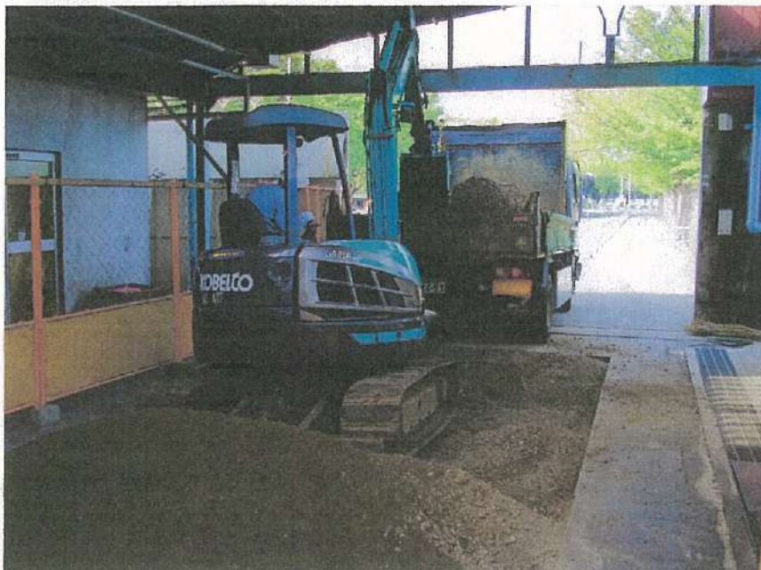
地下タンク設置工事 土工事 根伐 積込み状況
