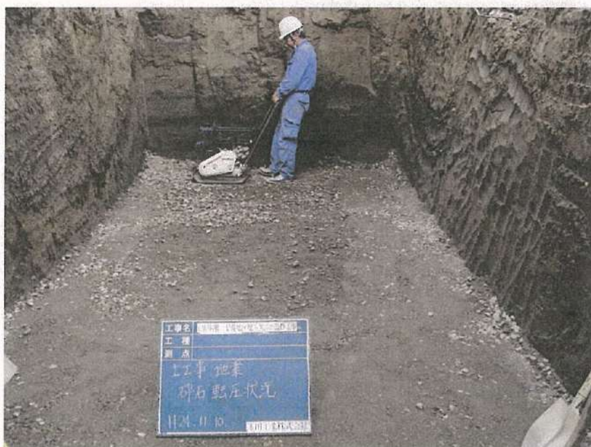
地下タンク設置工事 土工事 地業 碎石転圧状況
