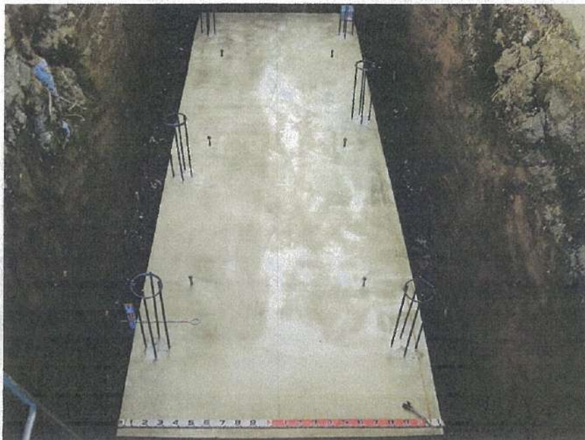
地下タンク設置工事 耐圧盤 コンクリート出来型 6,400×2,100 厚さ=300
