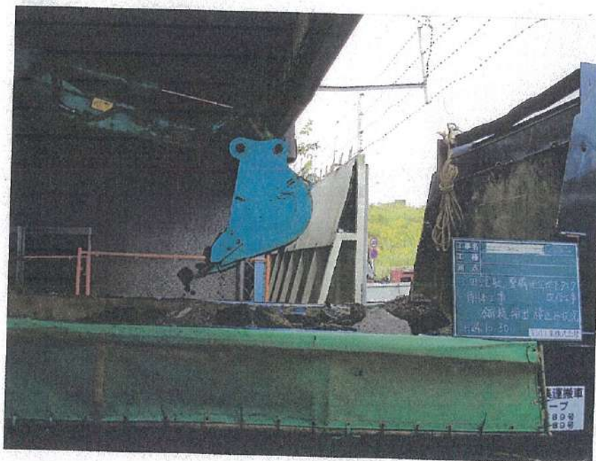
地下タンク設置工事 解体工事 舗装積込み状況
