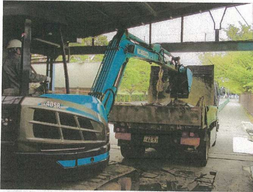
地下タンク設置工事 解体工事 舗装積み込み状況
