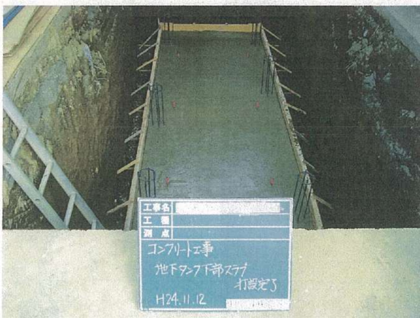
地下タンク設置工事 コンクリート工事 タンク下部スラブ 打設完了状況
