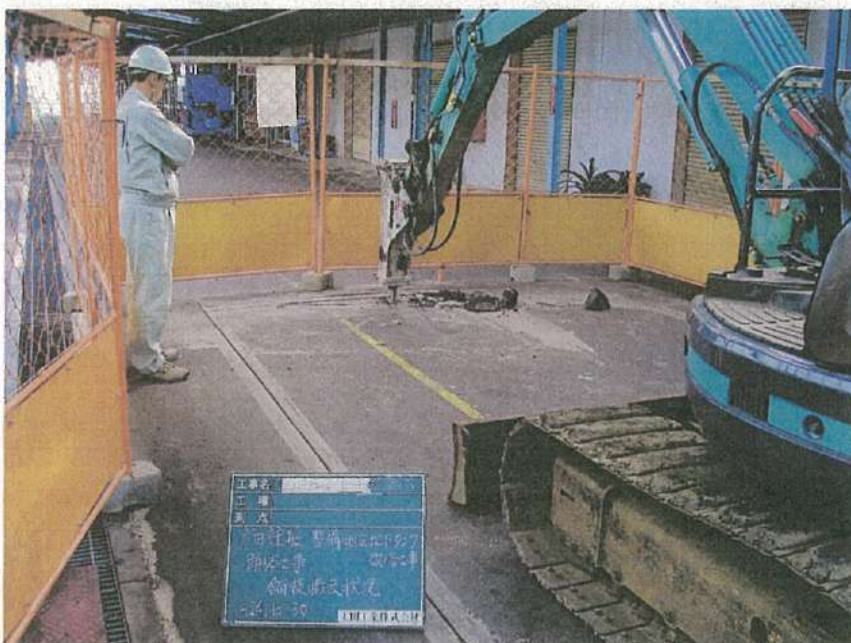
地下タンク設置工事 解体工事 舗装解体状況
