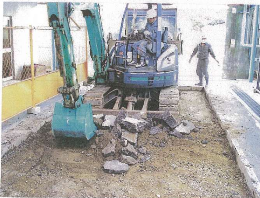
地下タンク設置工事 解体工事 舗装撤去状況
