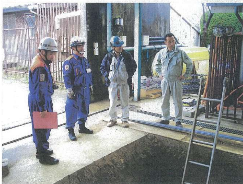
地下タンク設置工事 消防検査 タンク下部スラブ配筋検査 D13@300 (タテ、ヨコ共) ダブル配筋 厚さ=300
