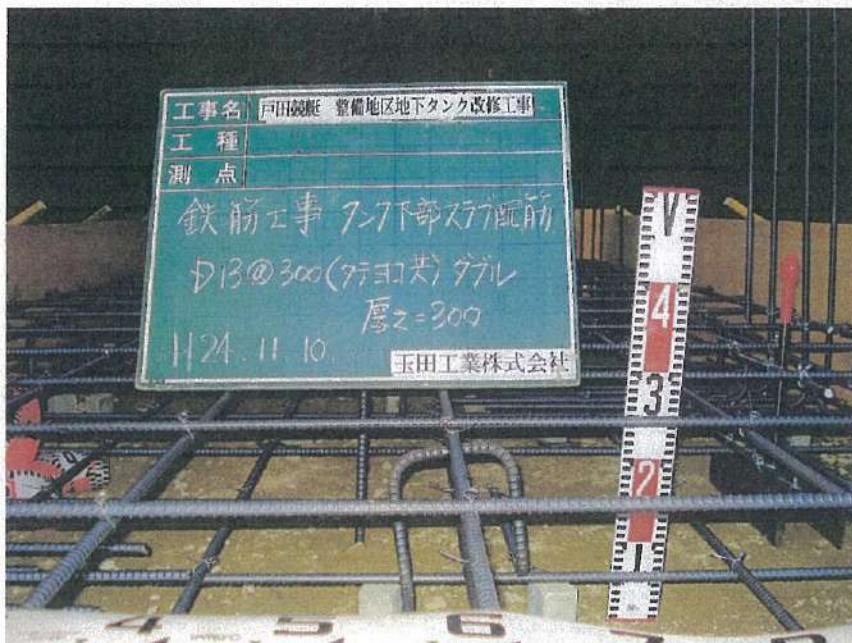
地下タンク設置工事 鉄筋工事 タンク下部スラブ配筋完了状況 D13@300 (タテ、ヨコ共) ダブル配筋 厚さ=300
