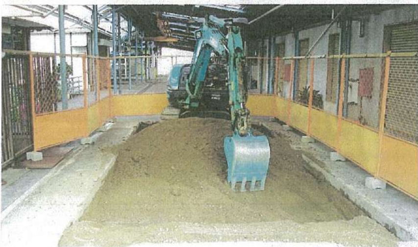
地下タンク設置工事 土工事 根伐 掘削状況
