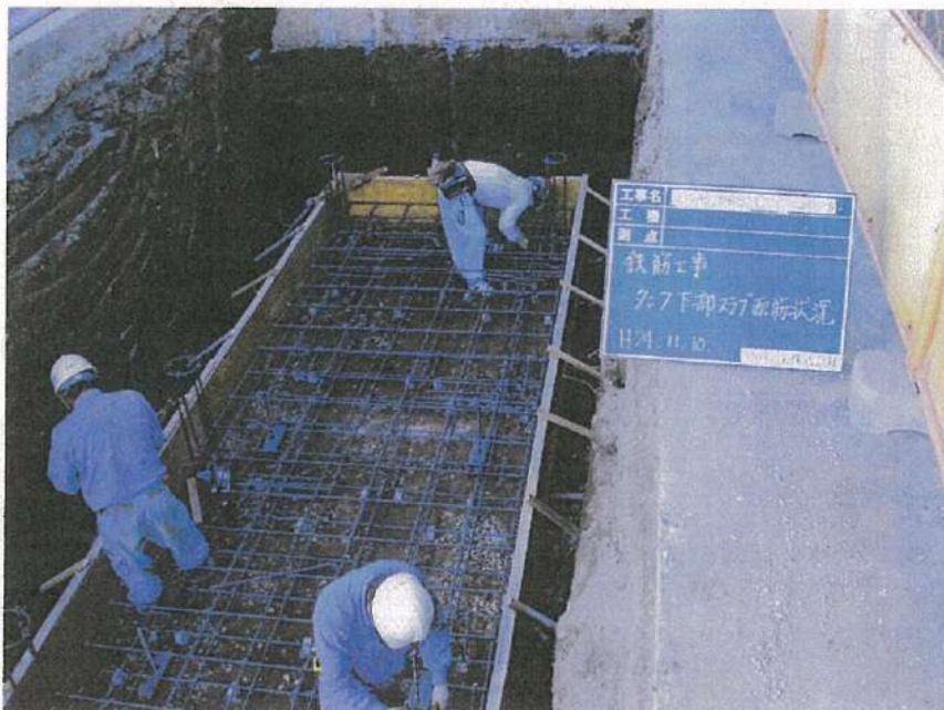
地下タンク設置工事 鉄筋工事 タンク下部スラブ配筋状況 D13@300 (タテ、ヨコ共) ダブル配筋 厚さ=300
