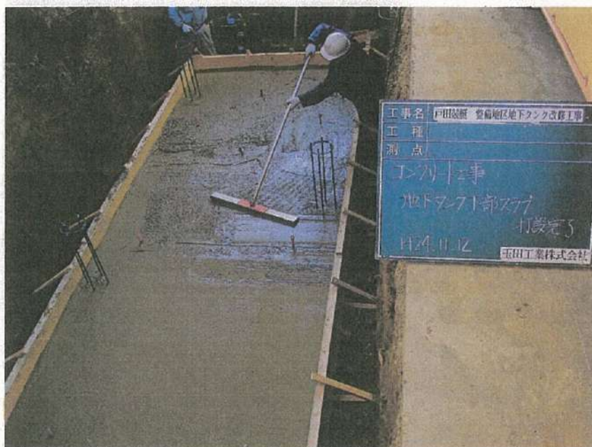
地下タンク設置工事 コンクリート工事 タンク下部スラブ打設状況
