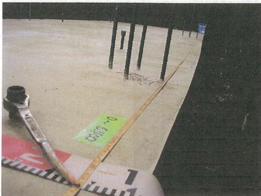
地下タンク設置工事 耐圧盤 コンクリート出来型 6,400×2,100 厚さ=300 0~6,400
