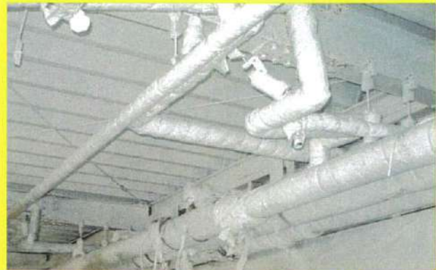
アスキヤッチ CW 塗布 (白色仕上げ)
