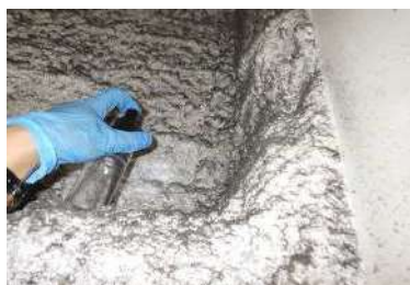
飛散防止措置剤噴霧状況
