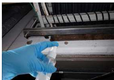
飛散防止措置剤噴霧状況
