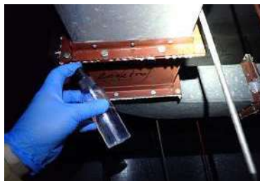
飛散防止措置剤噴霧状況
