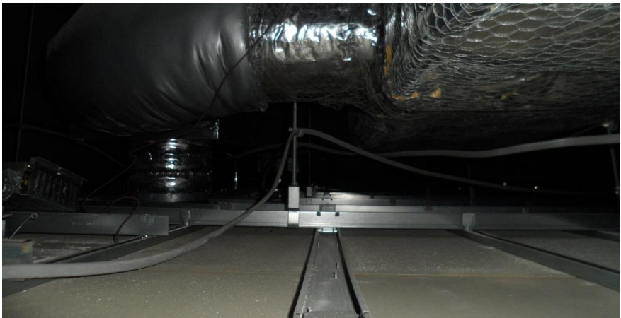
3F フードコート低天井
