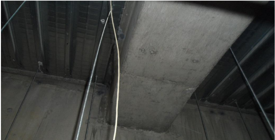
3F フードコート低天井
