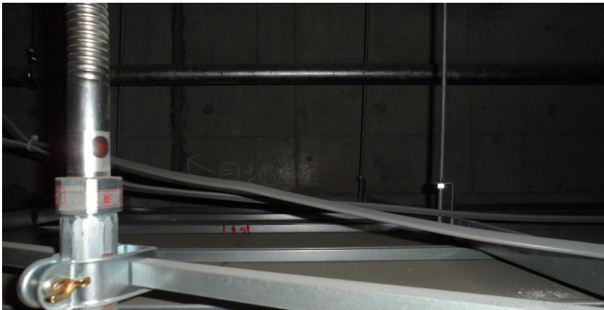
3F フードコート低天井
