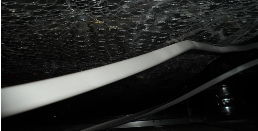
3F フードコート低天井
