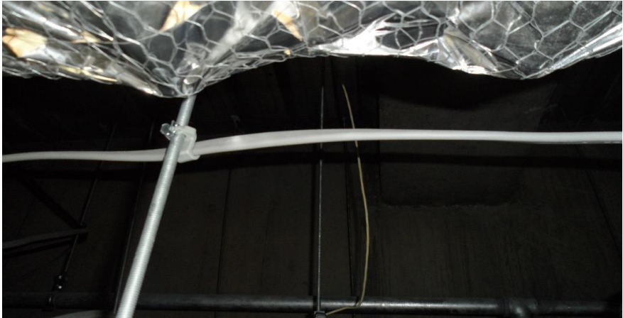
3F フードコート低天井
