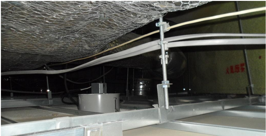
3F フードコート低天井
