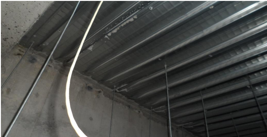
3F フードコート低天井
