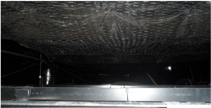
3F フードコート低天井
