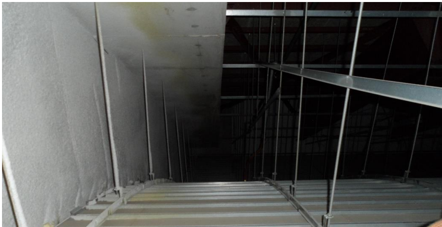
5F 2期スタンド 曲面天井
