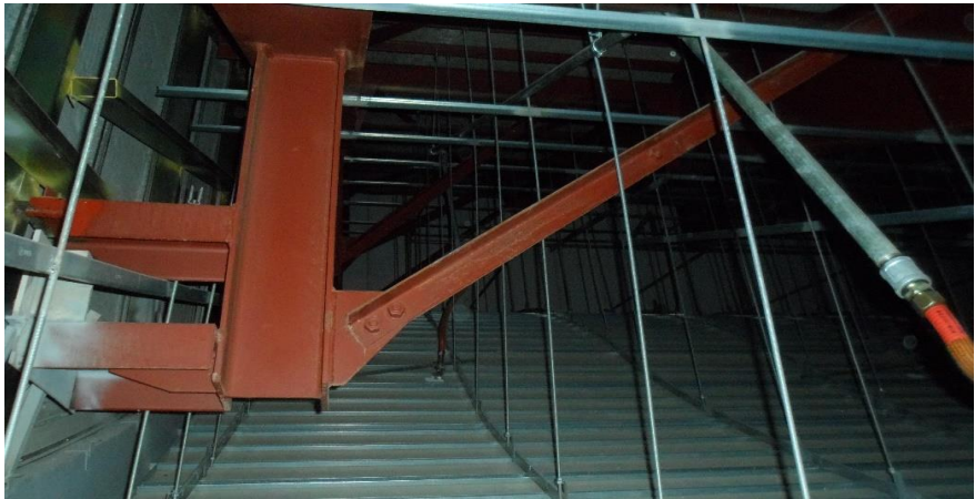
5F 2期スタンド 曲面天井
