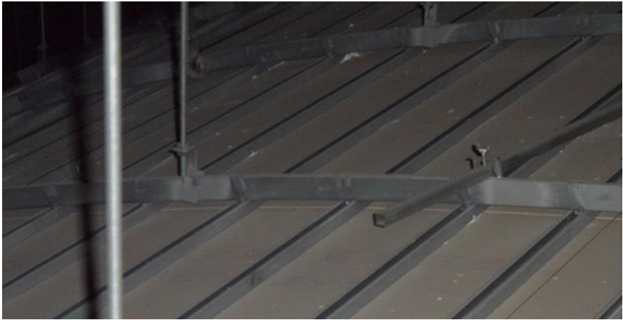
5F 2期スタンド 曲面天井
